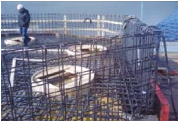
FIGURA 24. Fabricación de las prelosas en el muelle.
