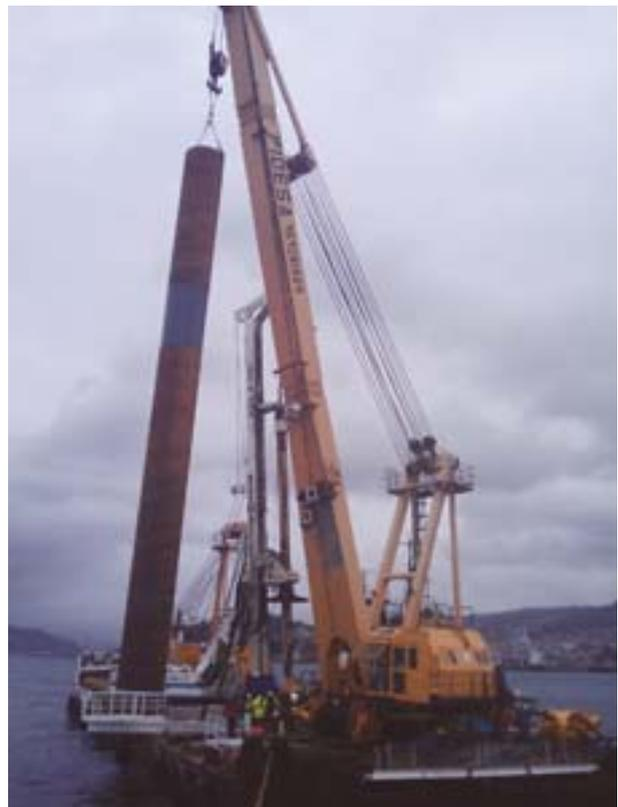
FIGURA 16. Colocación de la tubería en la plataforma auxiliar.
