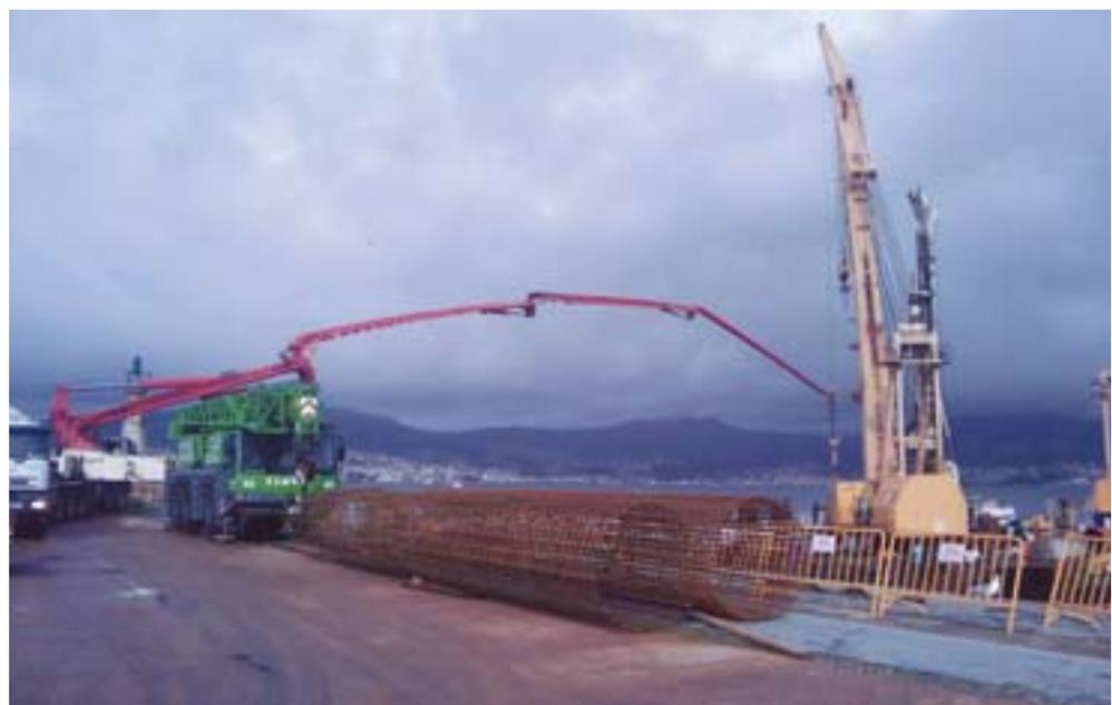
**FIGURA 21.** Hormigonado con bomba desde el muelle (DA 1).
