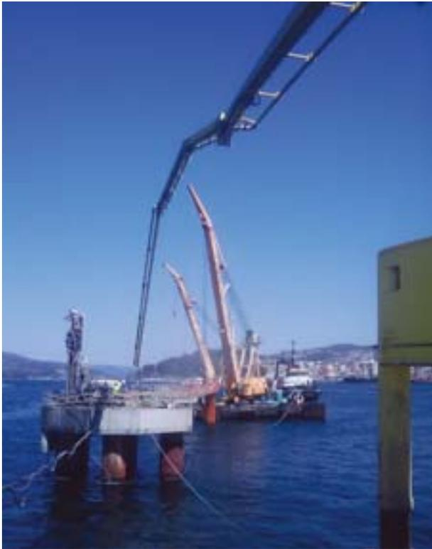
FIGURA 22. Hormigonado desde muelle con bomba y tubería (DA 3).
