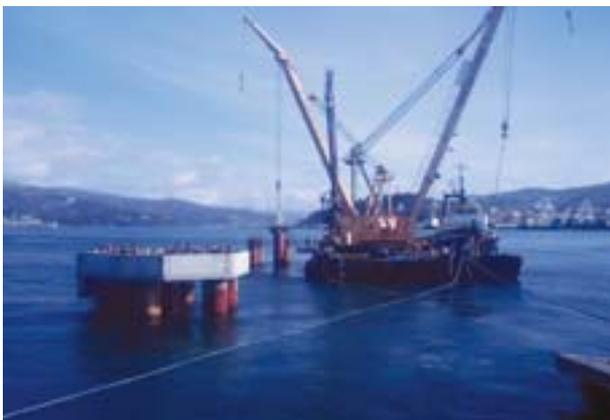
FIGURA 17. Vibrado de la tubería para su introducción en el terreno.
