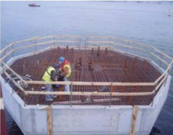
FIGURA 26. Armado del cabecero utilizando la prelosa como encofrado perdido.
