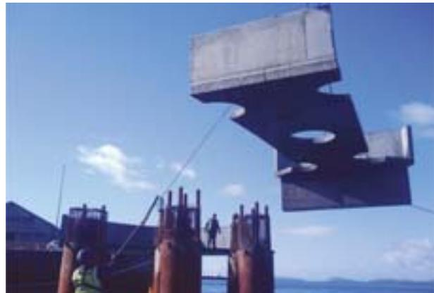
FIGURA 25. Colocación de un tramo de prelosa en el cabecero.
