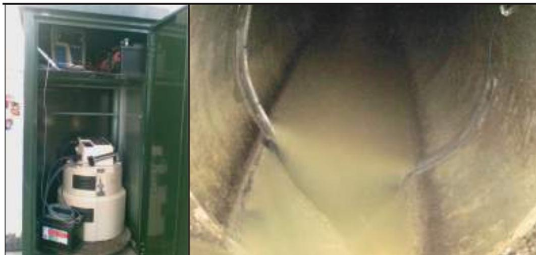
FIGURA 1. Sección de control (izq.) e instrumentación instalada en el colector (dcha.).
