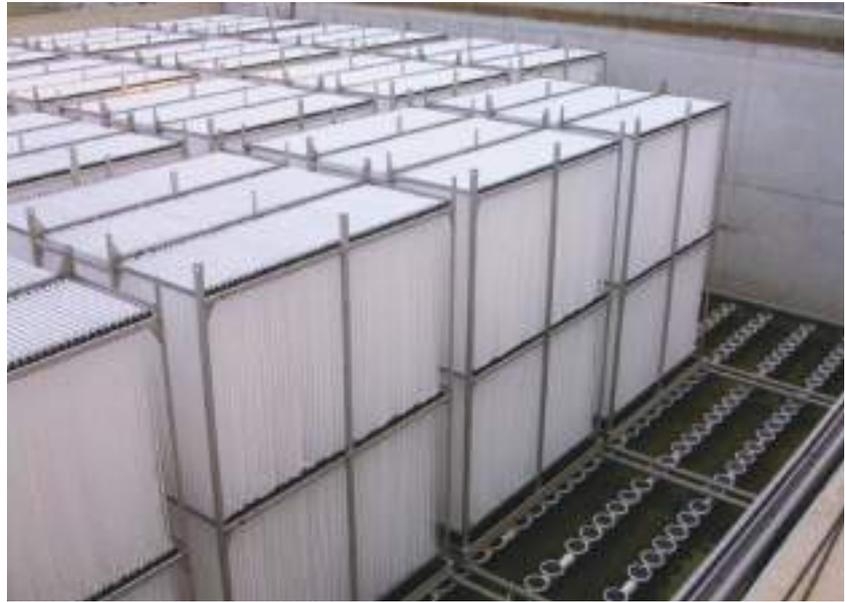
FIGURA 6. Bastidores Ifas en el reactor biológico.
