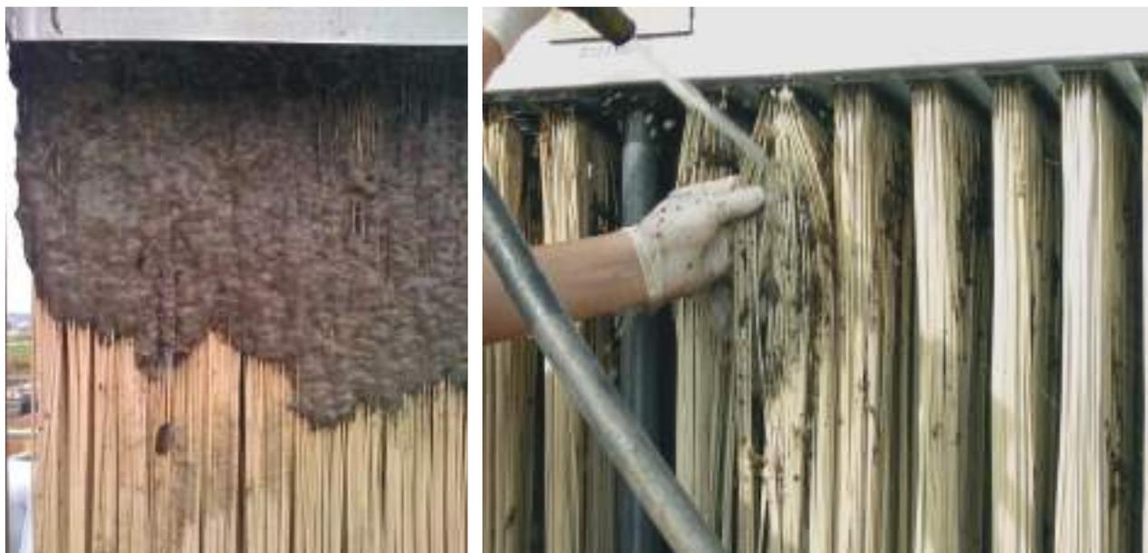
FIGURA 10. Izquierda: Ensuciamiento de membranas de FH; Derecha: Limpieza manual de membranas de FH.
