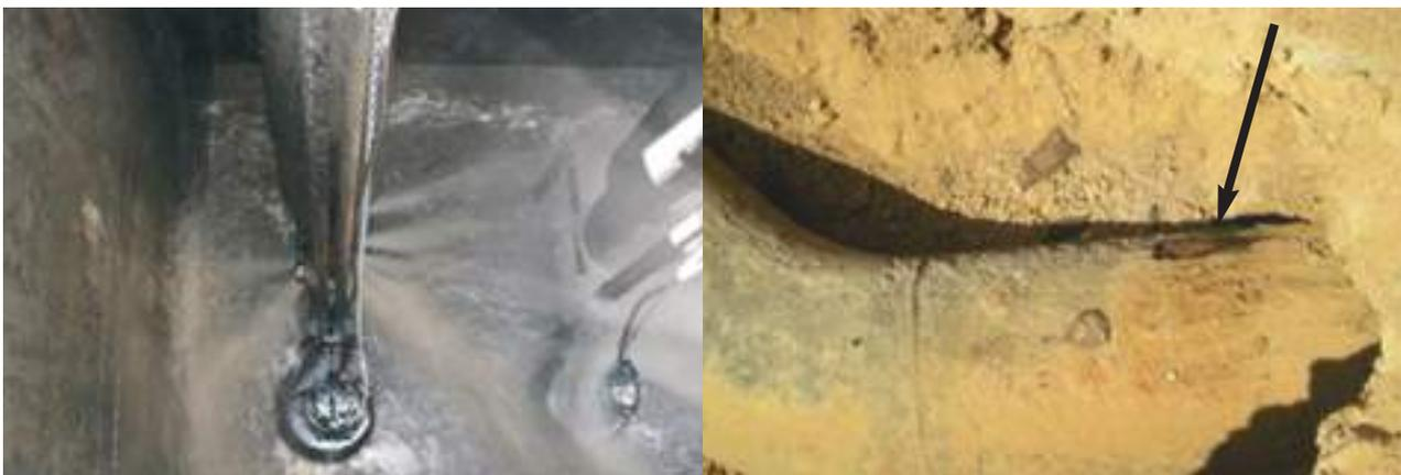
**FIGURA 9.** Detalle de conducciones dañadas. Disminución rendimiento hidráulico (izq.) y reducción eficiencia aireación (drcha.)
