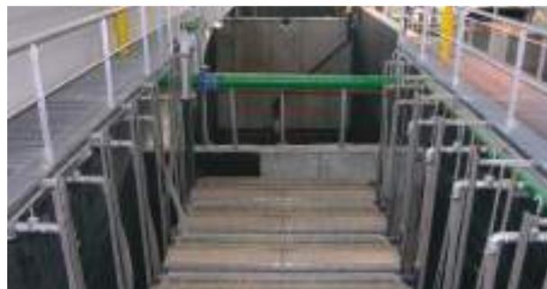
FIGURA 13. Tanque de membranas EDAR Illescas, Toledo.
