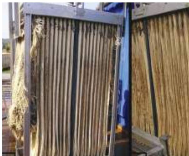
FIGURA 9. Rotura de membranas de FH.
