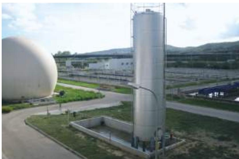
FIGURA 6. Fotografía del silo de almacenamiento de producto y del gasómetro de la EDAR Sant Feliu.
