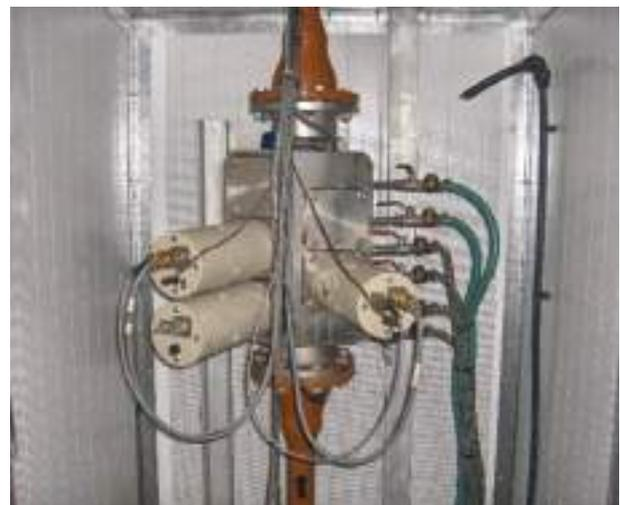
FIGURA 33. Equipo de hidrólisis SONIX en EDAR de Molina de Segura.
