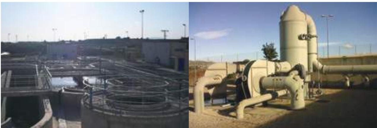
FIGURA 7. Detalle de: Varias líneas de tratamiento biológico (izq.); equipos de extracción de aire viciado de diversas potencias (drcha.)
