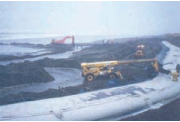
FIGURA 14. Geotubo en la playa. / FIGURE 14. Geotube on the beach.
