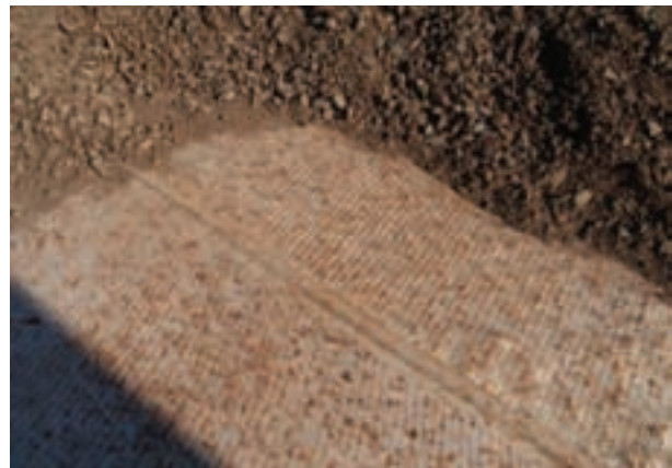
FIGURA 7. Detalle del solape del geosintético en la zanja excavada.
