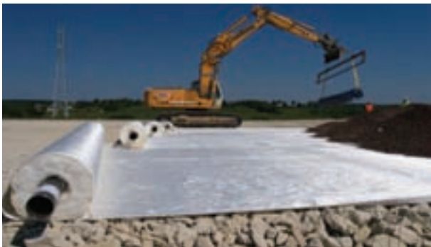
FIGURA 5. Colocación del geotextil.
