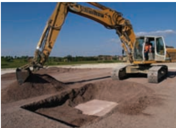
FIGURA 6. Excavación de la zanja para comprobar los daños por la colocación al geosintético.
