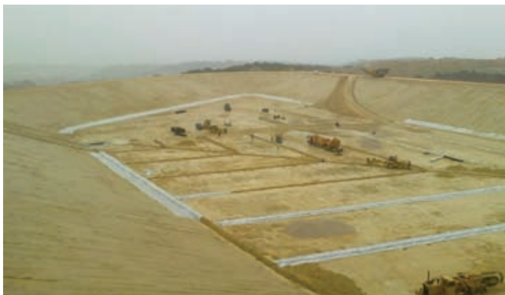
FIGURA 12. Aspecto general de los taludes una vez concluido el proceso.
