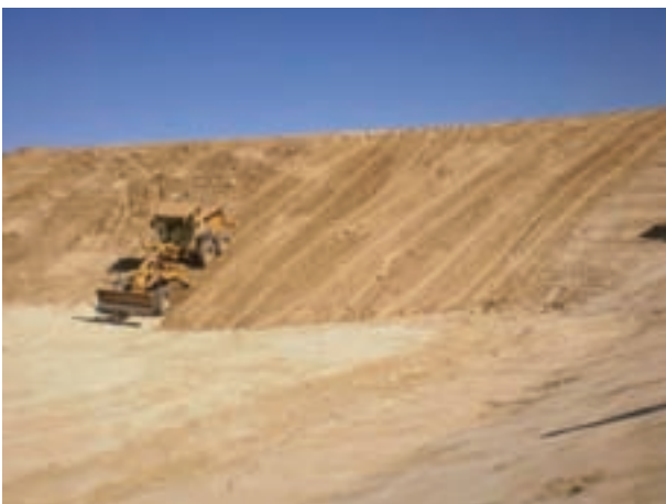
FIGURA 8. Extendido de la mezcla.
