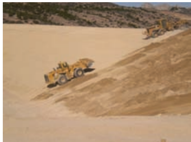
FIGURA 9. Extendido de la mezcla.
