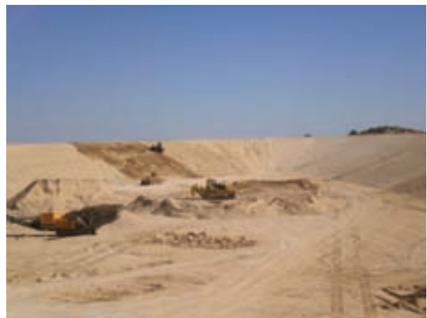
FIGURA 5. Mezclado de suelos.
