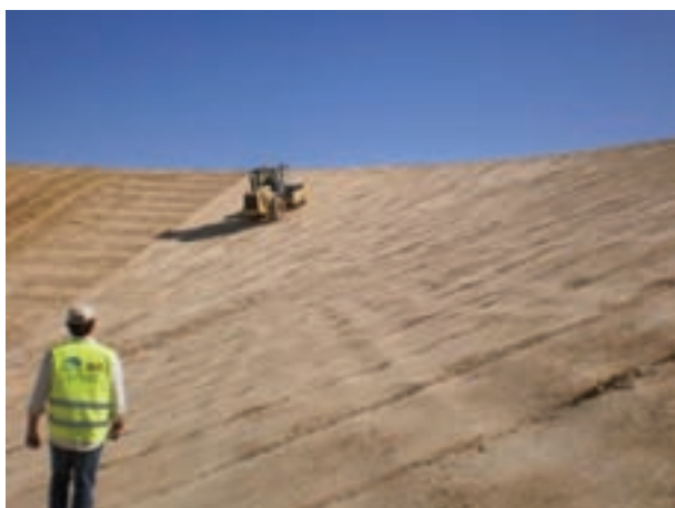
FIGURA 10. Compactado de la mezcla.
