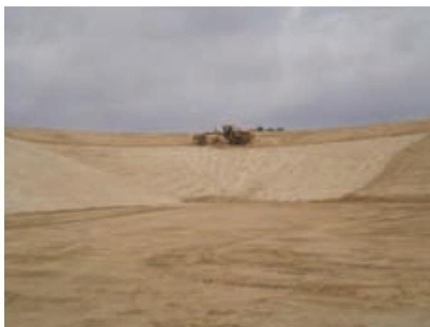
FIGURA 11. Refino de la mezcla.
