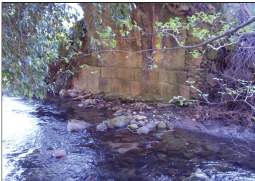
**Figura 6.** Cimentación del estribo derecho.
