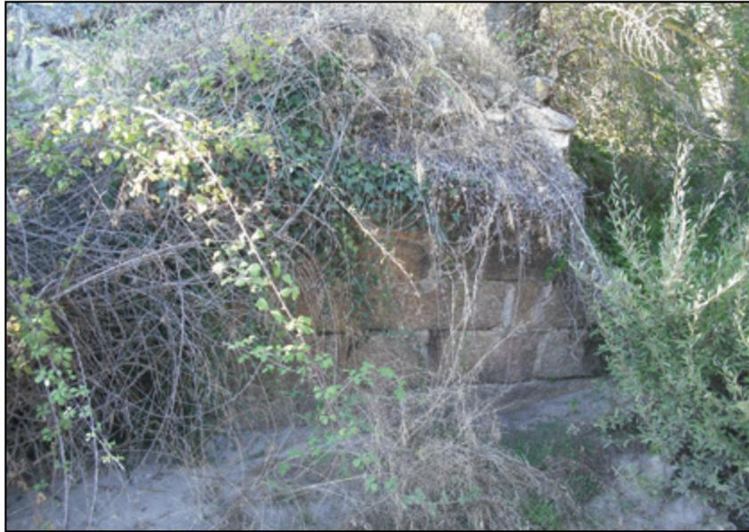
**Figura 36.** Sillares del estribo derecho del puente. Vista frontal.
