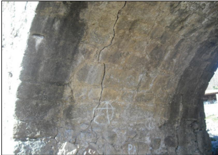
**Figura 52.** Fisuras longitudinales en la bóveda menor.
