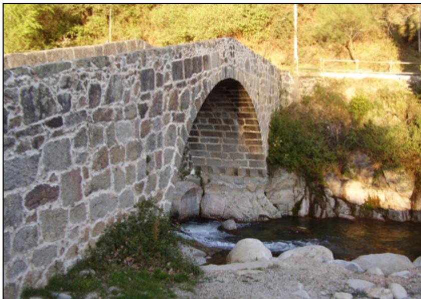
**Figura 9.** Manguardía de aguas abajo en el estribo derecho.
