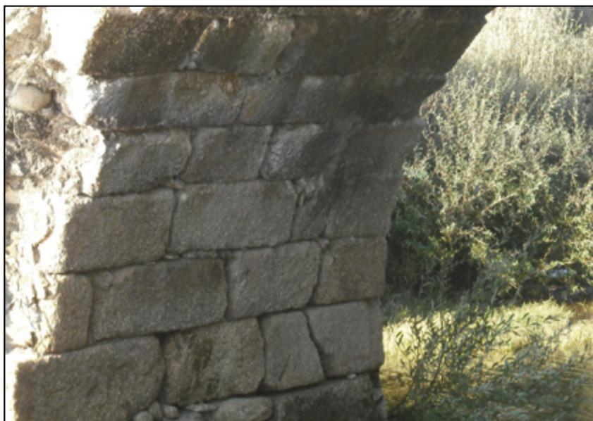
**Figura 33.** Detalle de los sillares.
