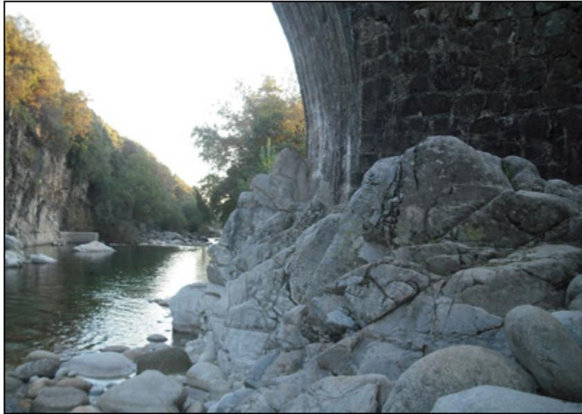
**Figura 47.** Cimentación estribo derecho.
