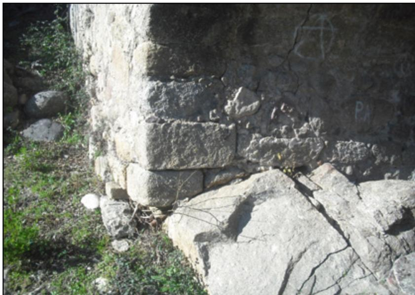
**Figura 53.** Cimentación aguas abajo del estribo derecho.
