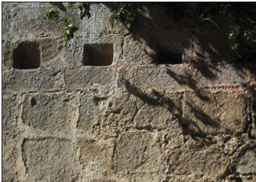
**Figura 15.** Detalle de los salmeres en el lado derecho del puente (derecho e izquierdo siempre visto desde aguas arriba).
