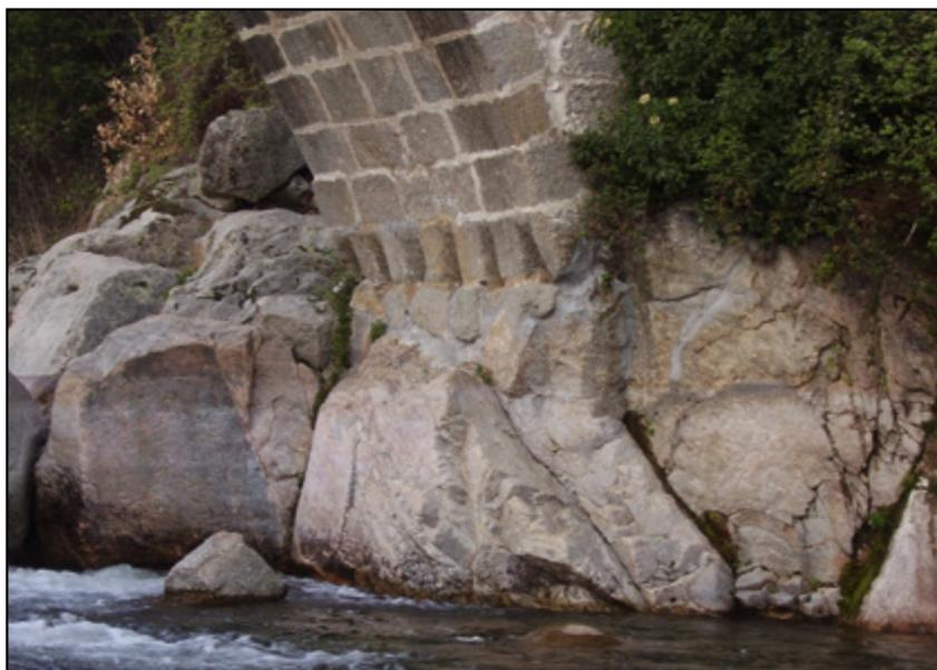
**Figura 11.** Cimentación de la bóveda en la roca.
