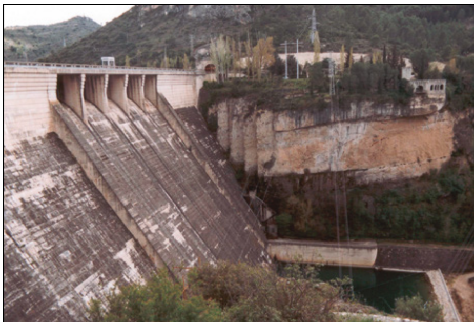
Figura 1. Presa de Entrepeñas. Aliviadero y cuenco amortiguador. Fuente: Documento XYZT.
