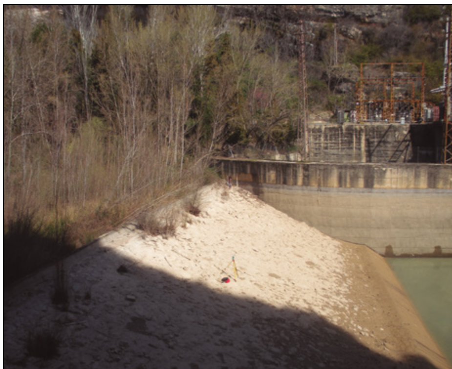
Figura 4. Presa de Entrepeñas. Cierre frontal del cuenco.
