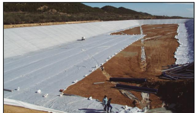
**Figura 8.** Geotextil de protección y filtro.
