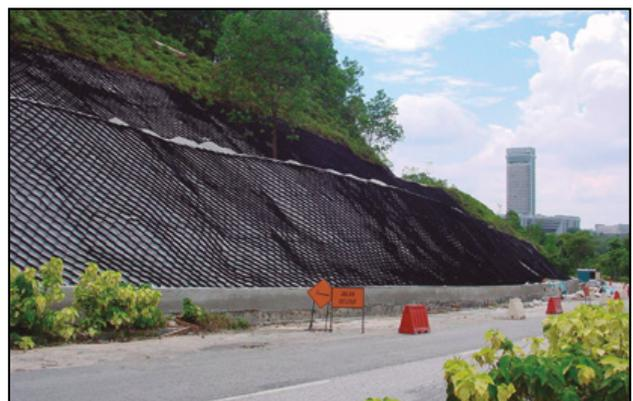
**Figura 12.** Geoceldas. Control de la erosión.
