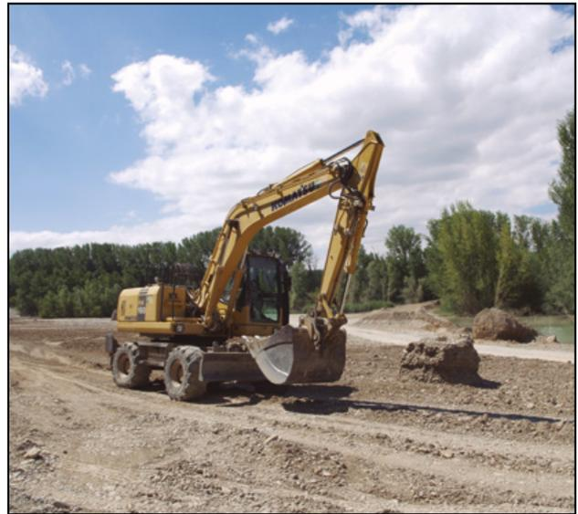
**Figura 6.** Excavación de la llanura de inundación y vertido de los sedimentos en el cauce del río Aragón, con el objeto de reducir el encajonamiento e incisión del cauce, y contribuir a la mejora de la funcionalidad hidrológica y ecológica del sistema fluvial.
