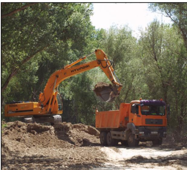
**Figura 5.** Eliminación de diques (motas) longitudinales y escolleras para la reconexión de los cauces con sus llanuras de inundación y la mejora de los procesos hidrológicos y ecológicos (río Aragón, Navarra).
