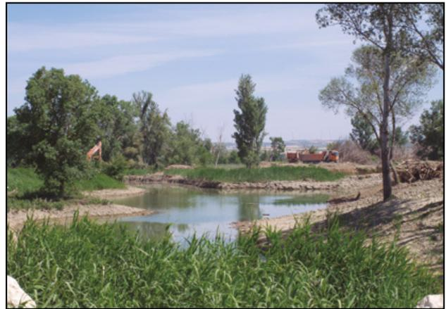
**Figura 7.** Creación de balsas – humedales que funcionan como zonas de retención de agua y refugio de interés para el visón europeo y para diferentes especies acuáticas y ribereñas. La pre-modelación topográfica e hidráulica (de la que se desprende la geometría de la balsa) asegura la funcionalidad de la actuación.
