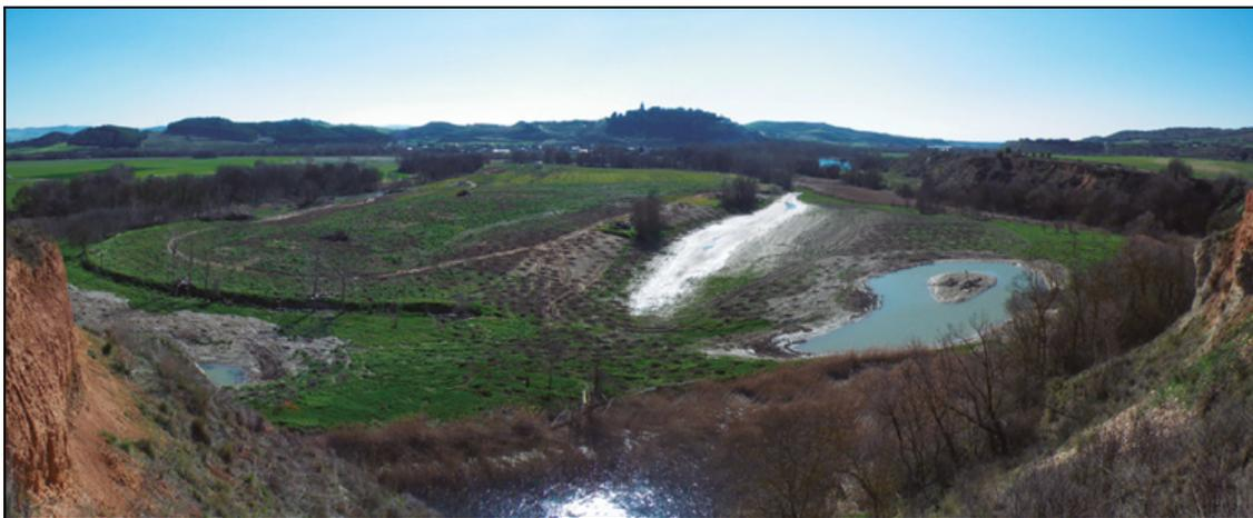
**Figura 1.** Trabajos de restauración del meandro del Plantío o de Rivalta (río Arga, Navarra), que incluyen diversas medidas de retención natural de agua, como la reapertura de paleo-cauces, la creación de humedales, la revegetación por bosques con especies autóctonas de genética local y la creación de diversos ambientes a través de una mayor heterogeneidad topográfica en el interior del meandro.
