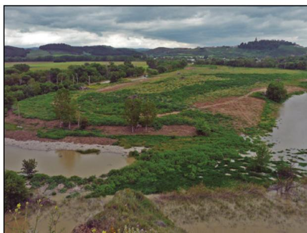
**Figura 2.** Vista parcial del meandro, en la primavera siguiente a la restauración (2010), donde se puede apreciar la evolución de la vegetación natural y su relación con la nueva topografía del cauce y con los nuevos procesos hidromorfológicos desarrollados en el interior del meandro.
