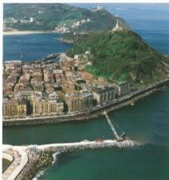
Dique y Regeneración Playa de Zurriola. San Sebastián
