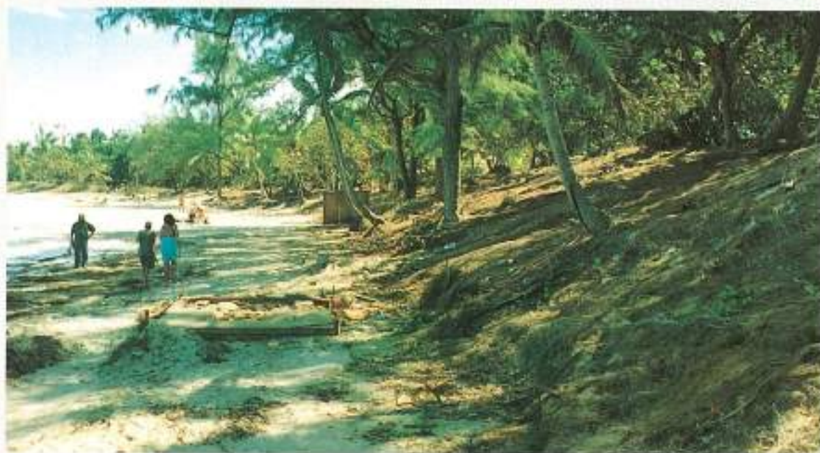
FOTOS 7 Y 8. Escarpes en la duna y afloramientos de superficies rocosas en Las Américas. Evidencias de erosión.
