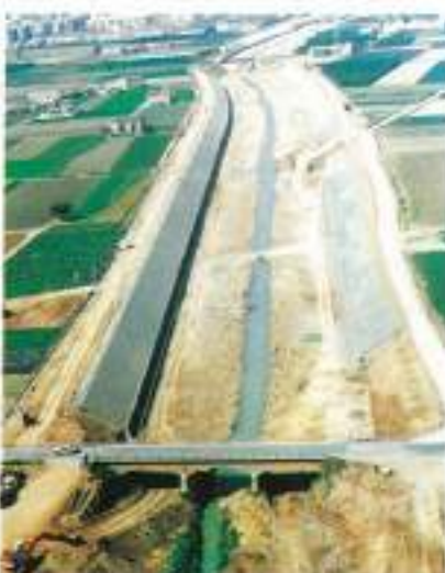
Encauzamiento del Barranco del Carraixet.
