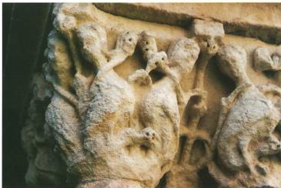
FIGURA 9. Erosión generalizada en el capitel 56.
