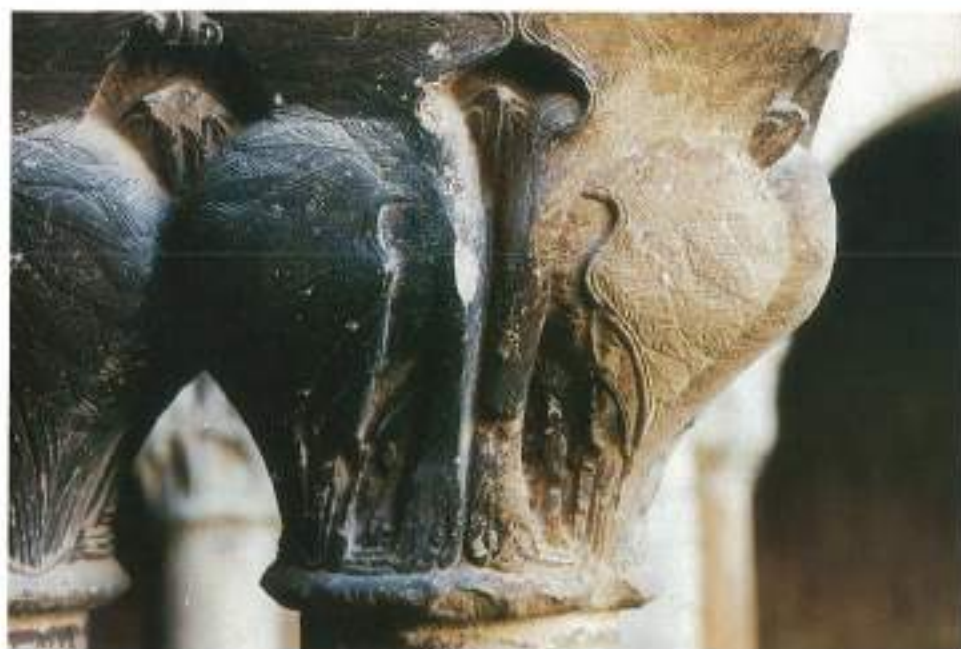
FIGURA 3. Pátina de color negro en la parte interior (izquierda en la imagen) y de decoloración natural en la parte exterior del capitel 3.
