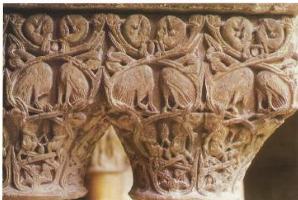
FIGURA 13. Ejemplo de grado de deterioro 2 (capitel 36).
