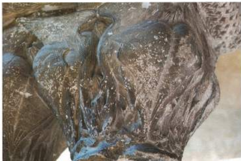
FIGURA 5. Picaduras, de aspecto puntiforme, en el capitel 11.
