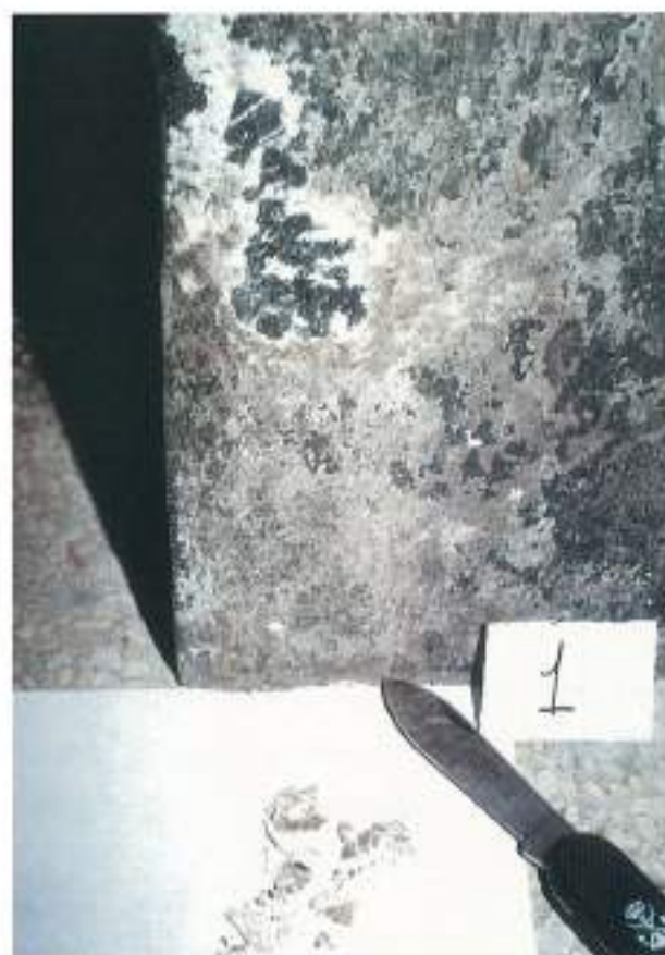
FOTO 6. Extracción de sales cristalizadas en superficie. La acumulación puede alcanzar espesores de 5 a 10 mm.
