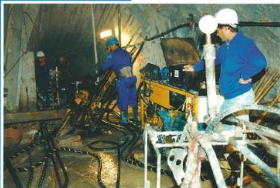
Presa de Tous. (Valencia) Realización en galería de pantallas de impermeabilización y drenaje.
