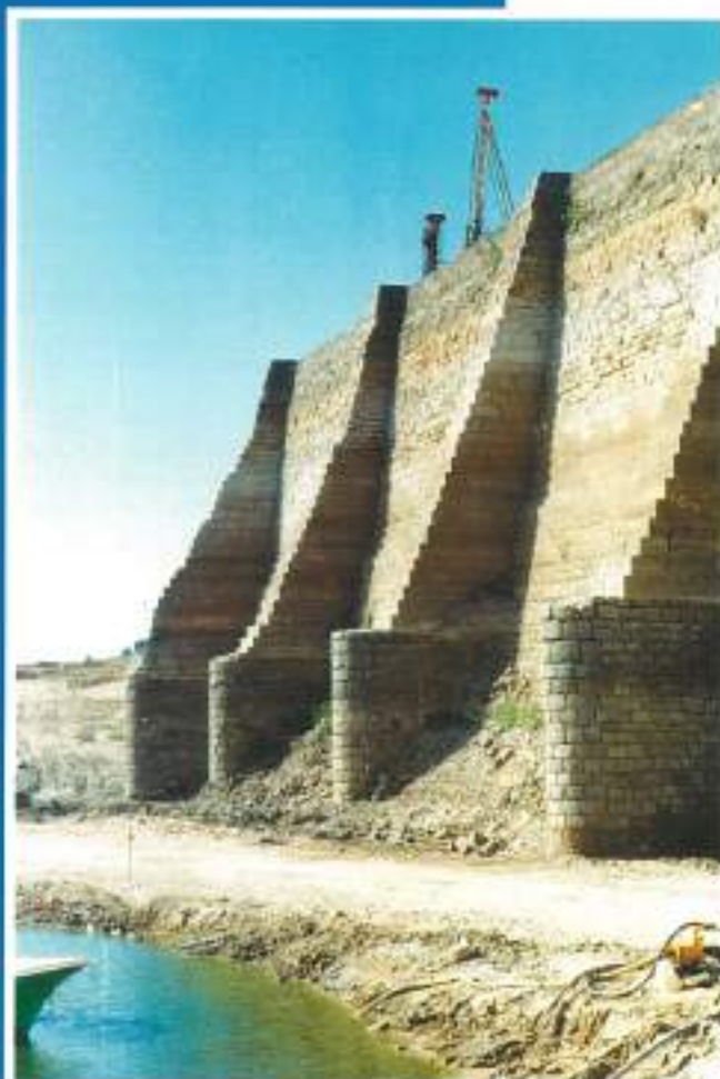
Presa romana de Proserpina. (Badajoz) Inyecciones de consolidación y cosido del paramento de la presa.
