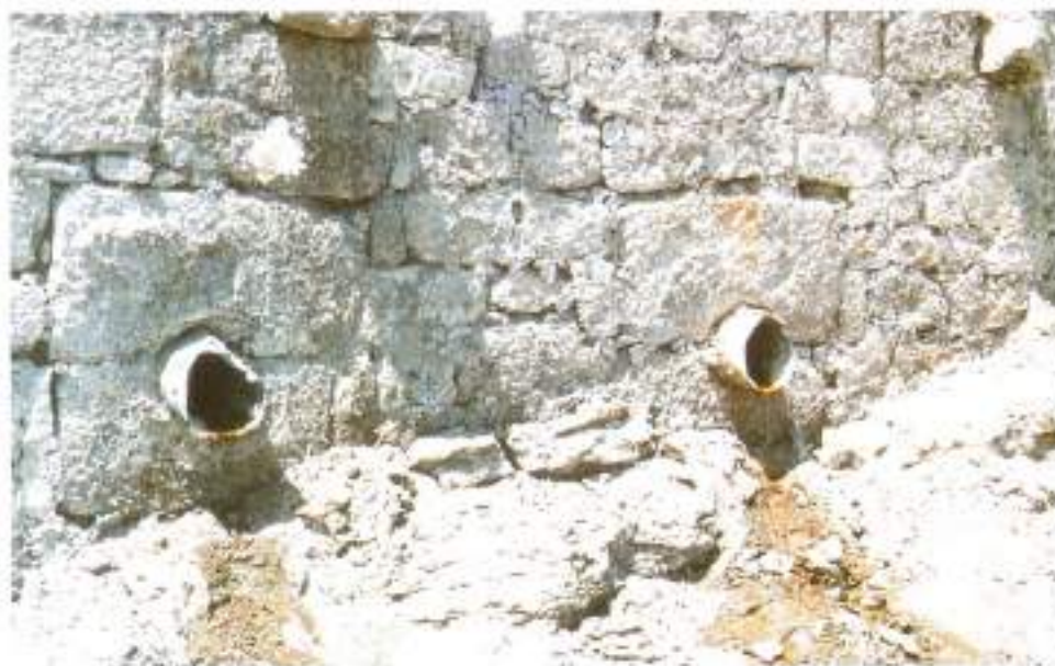
FOTO 5. Desagües de fondo de la presa, descubiertos durante la rehabilitación.
