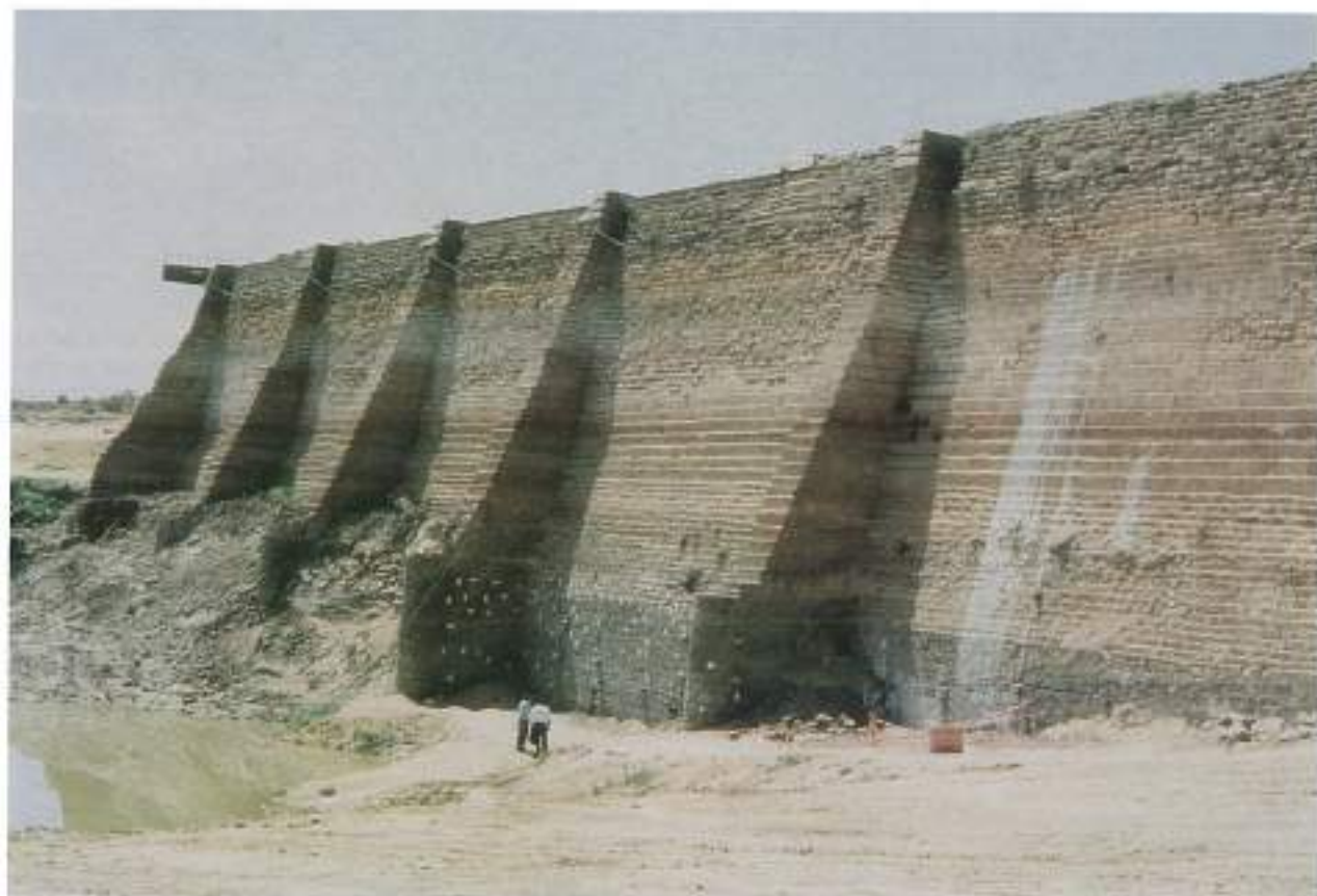
FOTO 4. Vista general de la presa aguas arriba, durante el desembalse.
