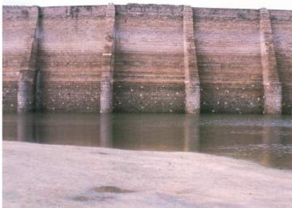
FOTO 3. Vista general de la presa aguas arriba. La parte inferior, que destaca por su diferente coloración, corresponde a la primera presa.
