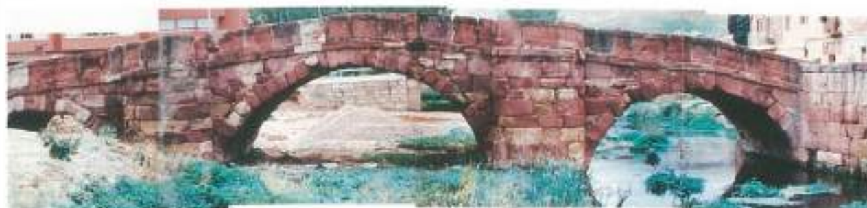
FOTO 1. Aspecto general del puente de Molina o "Puente Viejo".
