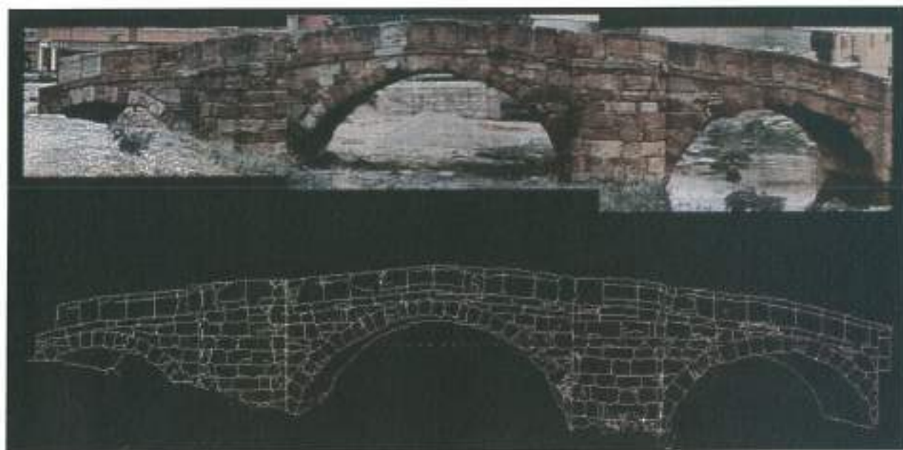
IMAGEN 1. Imagen digitalizada e integrada en un fichero único, conteniendo el puente y un plano del mismo, con los sillares correspondientes.
