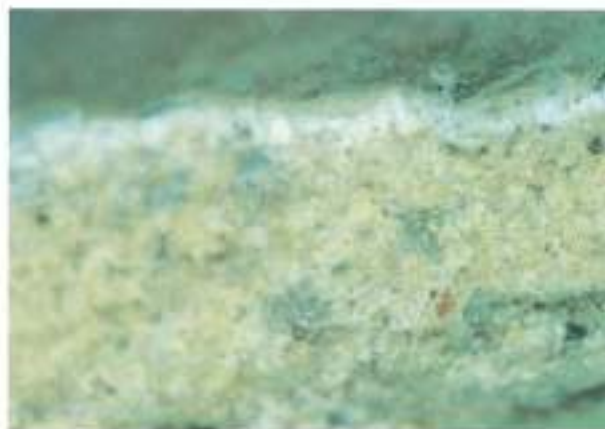
FIGURA 7. Presencia de yeso como "acabado" de los estucos. Fotografía correspondiente a la muestra C-53.
