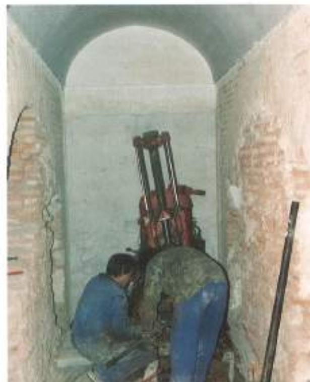
FOTO 10. Sondeo inclinado en uno de los salones de la Torre de Canales.
