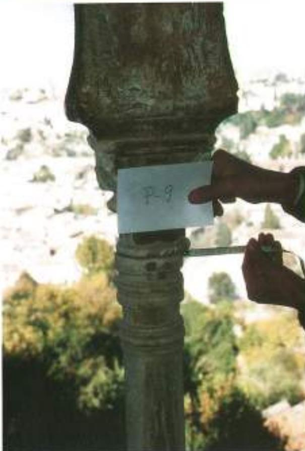
FOTO 6. Desajuste en los elementos de un arco bífido de la Torre de los Picos.
