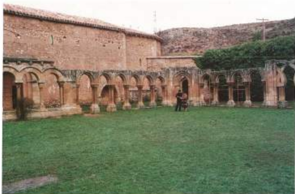
FOTO 8. Alteración cromática en las basas y parte superior de los arcos.
