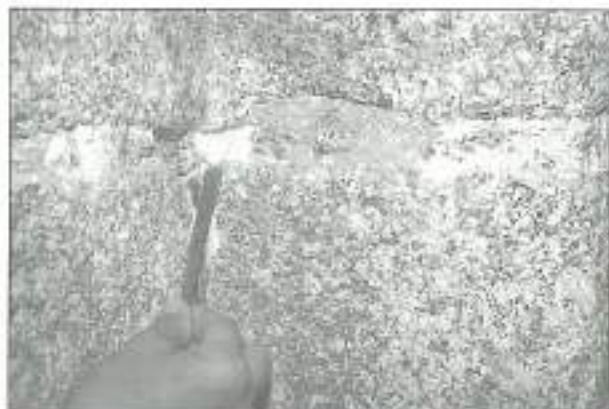
FIGURA 16. Aspecto de la formación de sales en los rellenos entre sillares graníticos.
