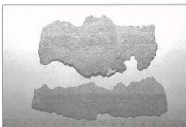
FIGURA 14. Costra de yesificación formada en las llagas, entre sillares de Granito. Al formarse la costra, arranca el relleno de la llaga y la superficie de los sillares adyacentes.
