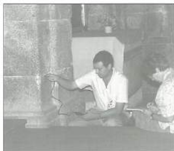
FIGURA 5. Determinación de humedades, en el machón-columna, centro derecha de la Capilla del Patrocinio.
