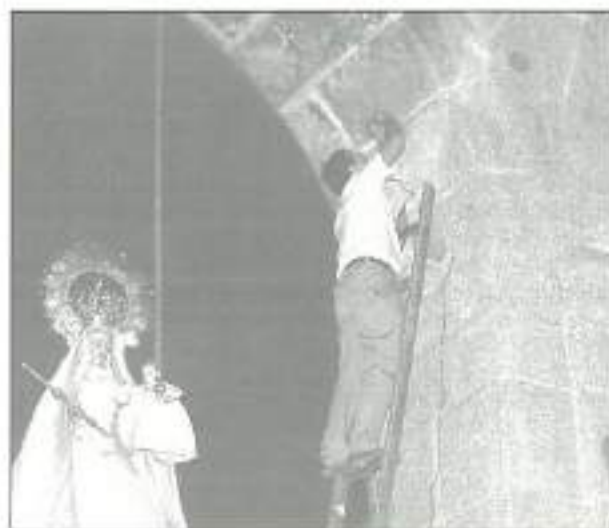
FIGURA 6. Determinación de humedades, en la parte superior de la bóveda central, de la Capilla del Patrocinio.
