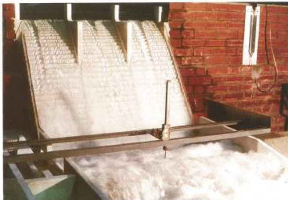
FOTO 1. Aliviadero escalonado de la presa de Alcollarín.
