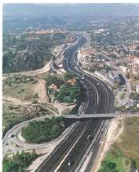
Acondicionamiento CN-VI. Ensanche a tres carriles. Tramo :Las Rozas-Villalba
