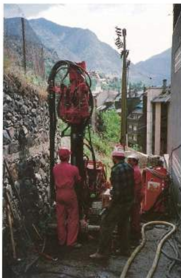
FOTO 1. Equipo de sondeos KLEMM MR-70, doble cabezal de rotoperforación en cabeza.
