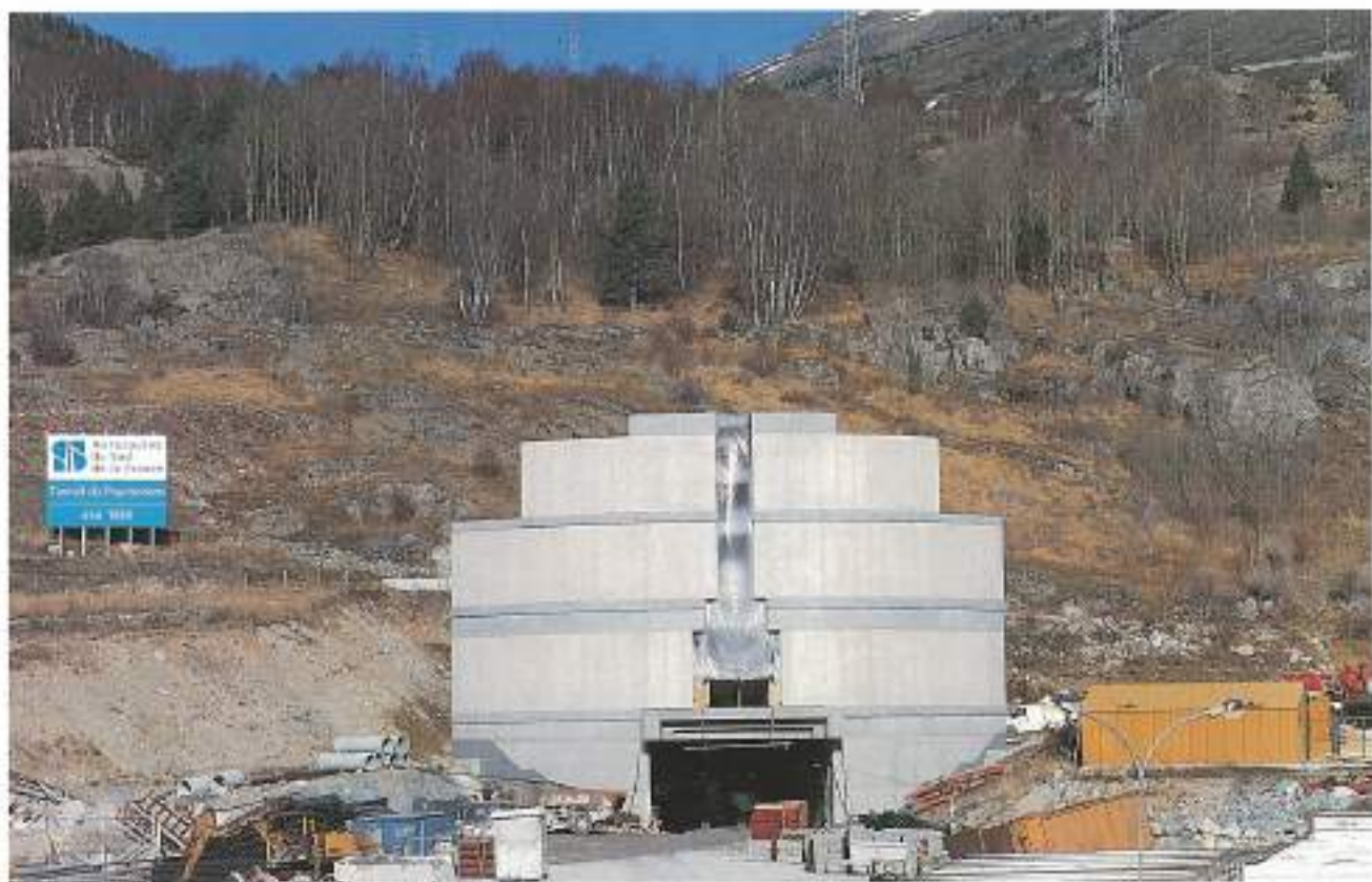
Túnel de Puymoreno Pireneo Oriental 4.520 m. de longitud (Impermeabilizado con DRAYFIL Túnel)
