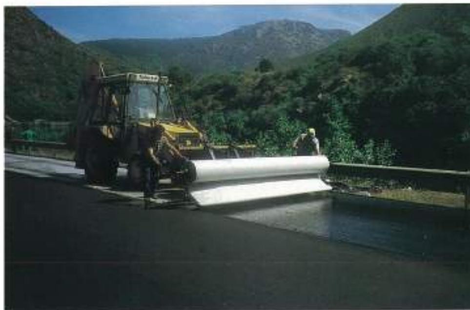
FOTO 2. Extendido del geotextil sobre el firme existente.
