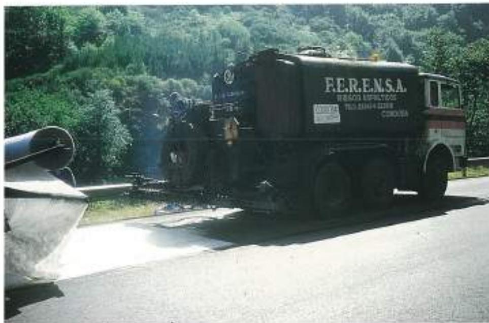
FOTO 1. Avance del riego en caliente, previo al extendido del geotextil.
