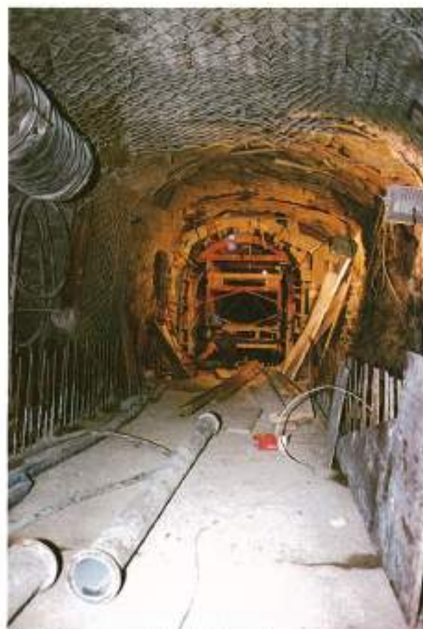
FOTO 4. Revestimiento de la galería de control.
