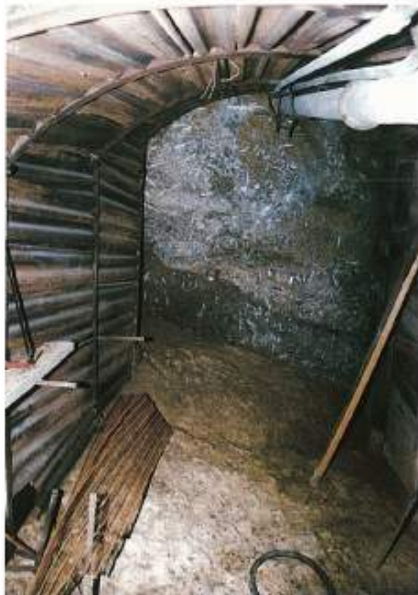
FOTO 2. Galería de sustitución dispuesta para el hormigonado.
