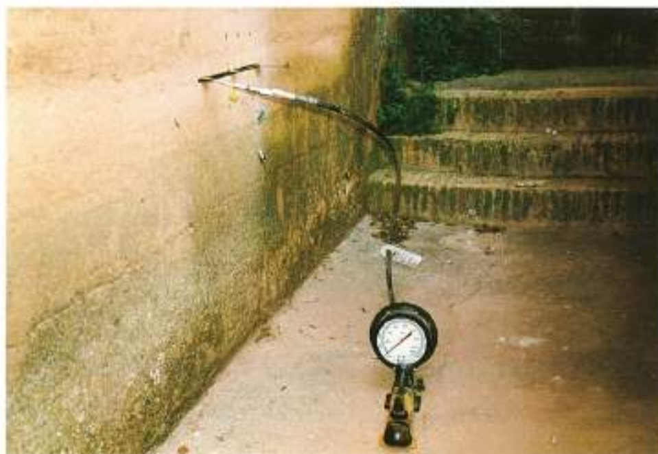
FIGURA 14. Colocación del gato plano y las puntas de base extensométrica.
