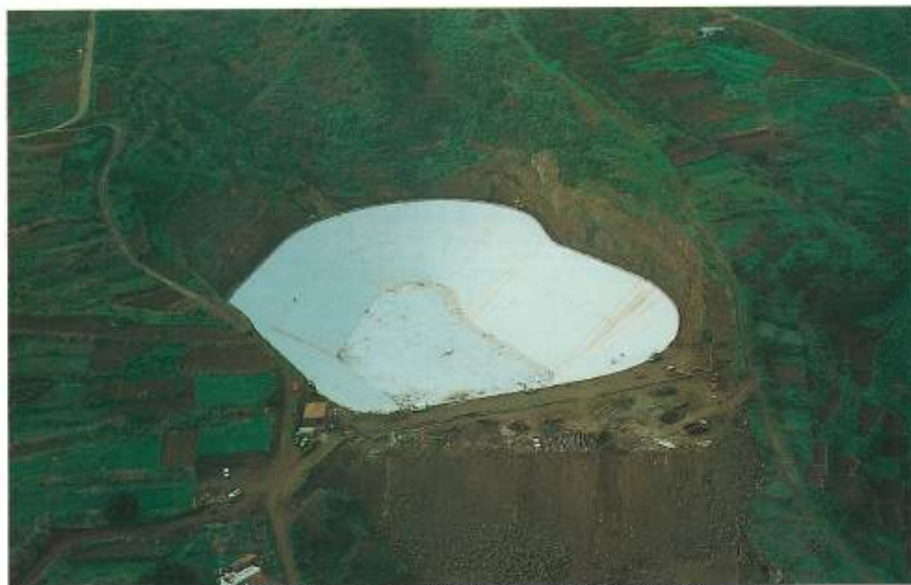
Embalse de Adayahemen, capacidad 339.000 m 3 Isla de La Palma CANARIAS (impermeabilizado con DRAYFIL Embalses).
