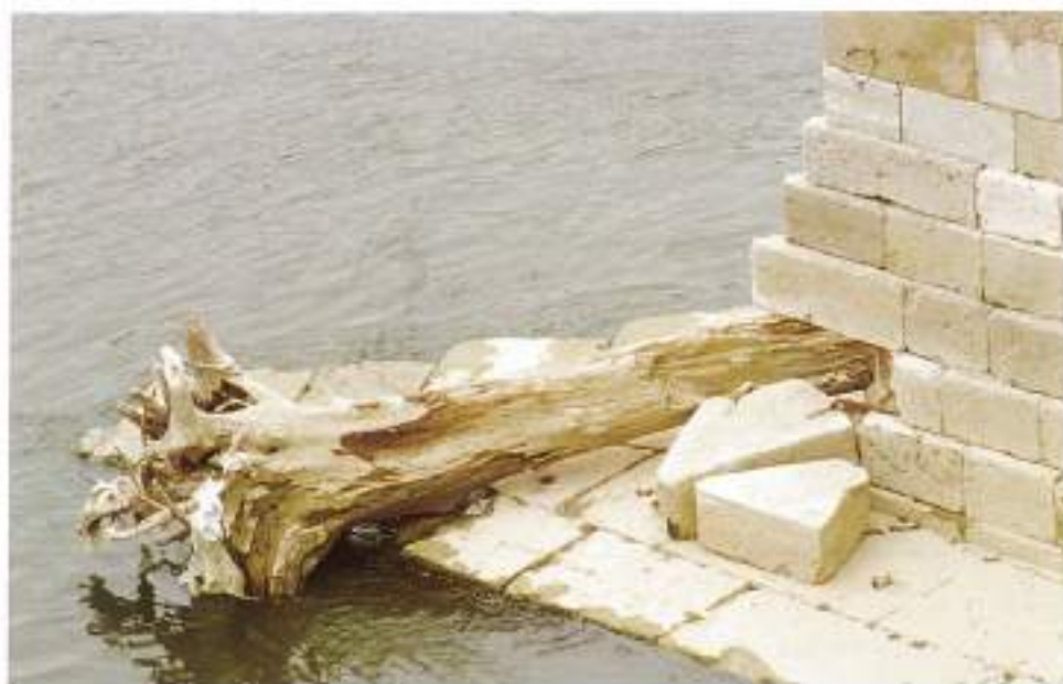
Todos los puentes construidos en la época del estudio poseían los cuchillos o tajamares en ángulo obtuso o en redondo, decían al respecto los "Ventilón libros...". "...en ninguna manera se hagan acúlos porque se rompen con las cosas que traían las rias con las crecidas...". En el siglo XVI no se tuvo en cuenta el reformar el puente de Piedra de Zaragoza, como podemos ver en la imagen.
