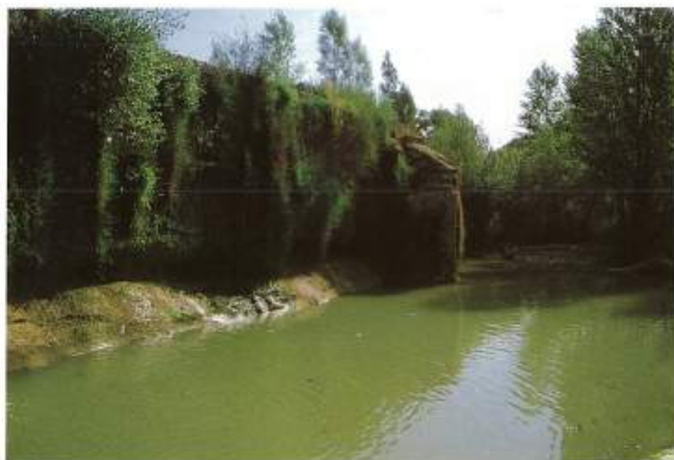
Azud Pueyo, obra de Juan de Aracil en 1578.
