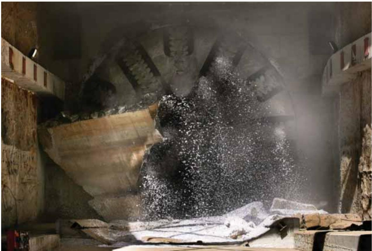
FIGURA 8. Cabeza de corte EPB del a TBM "Besi" (UTE Triangle). Cale en el Pozo de Cruce.
