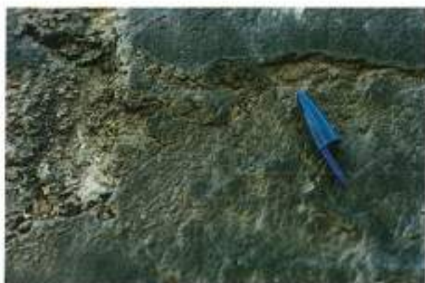
FIGURA 6. Aspecto de la costra negra en la portada de la Coronera.
