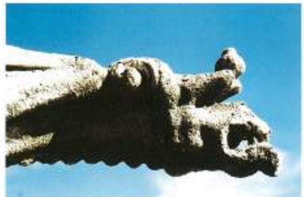
FIGURA 11. Abrasión en las górgolas del cimborio.
