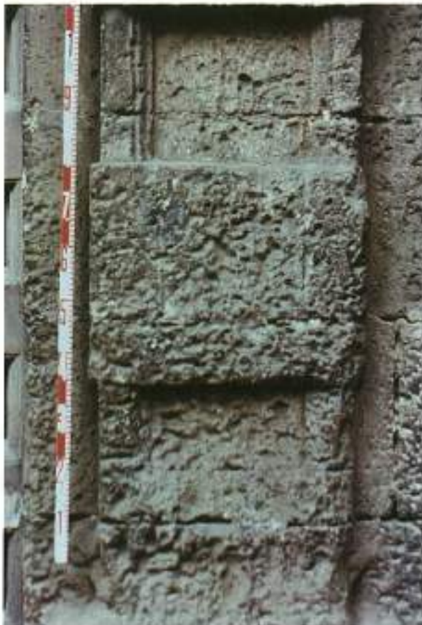
FIGURA 10. Alveolización que hacia la parte superior pasa a picado en la portada de la Coronera.
