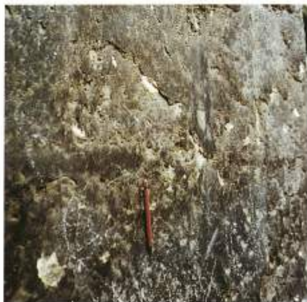
FIGURA 12. Desplazación y desarrollo de nueva costra negra en los contrafuertes de la portada de la Coronera.
