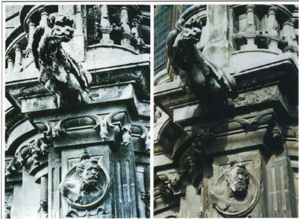
FIGURAS 17 A y B. Diferencia en el estado de alteración entre los años 1958 (A) y 1992 (B).
