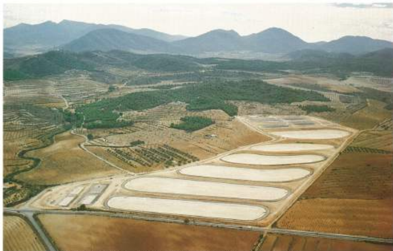
Depuradora de aguas residuales Bulea MURCIA. 120.000 m 2 (Impermeabilizada con lámina DRAYFIL. Embalses)
