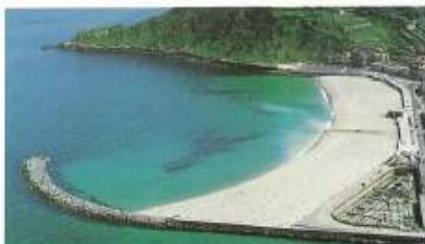
Dique y Regeneración Playa Zurriola. San Sebastián
