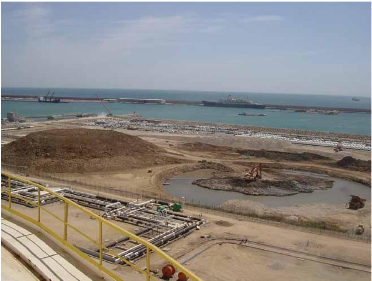
FIGURA 12. Precarga del TK-3000 y sustitución en el TK-3001.
