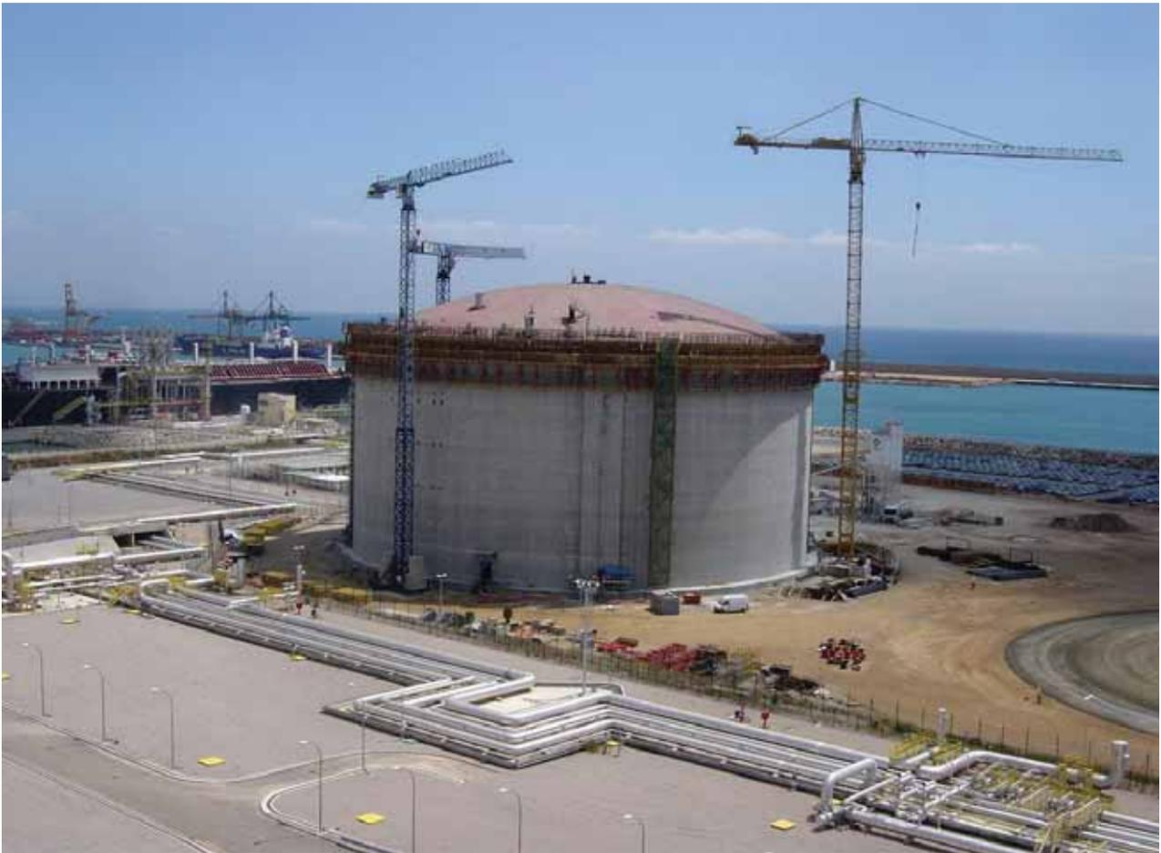
FIGURA 4. Tanque exterior y encofrado de la cúpula.
