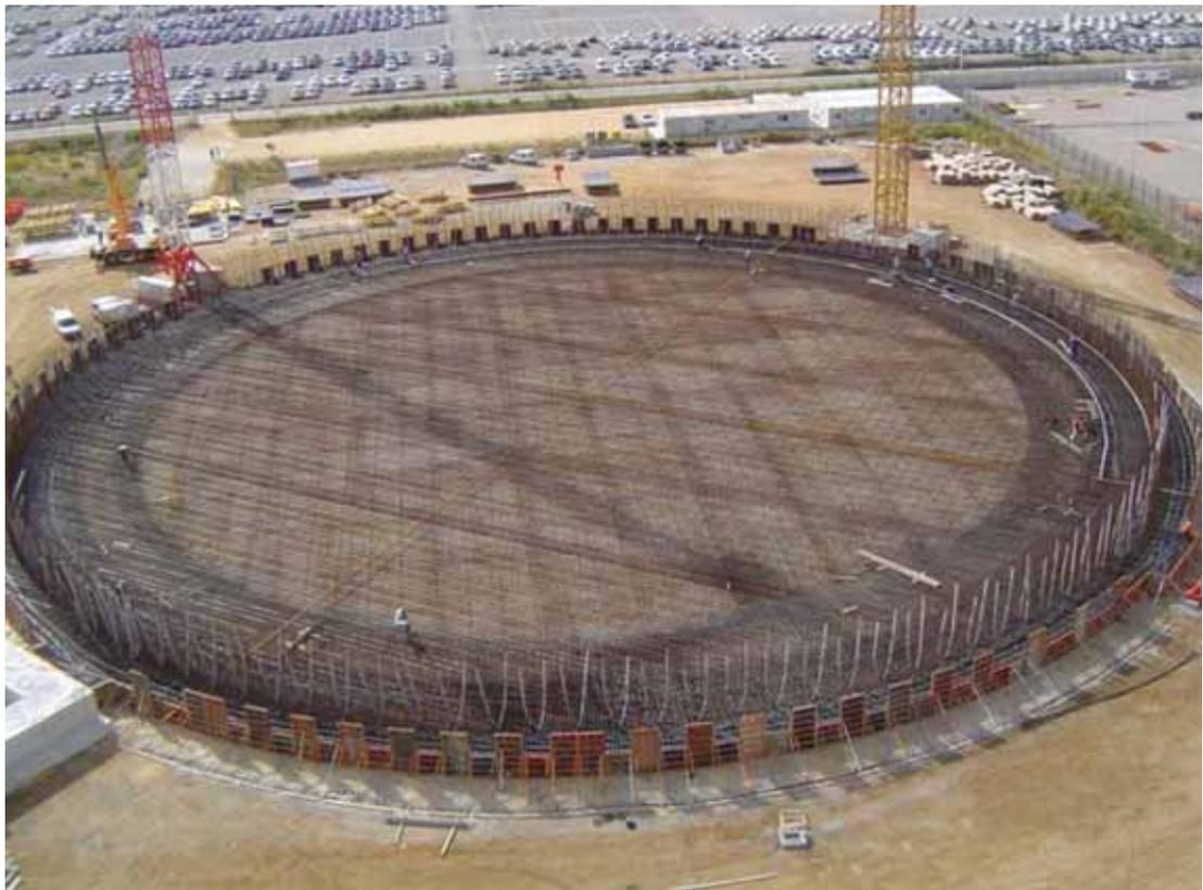
FIGURA 3. Armado de la losa.
