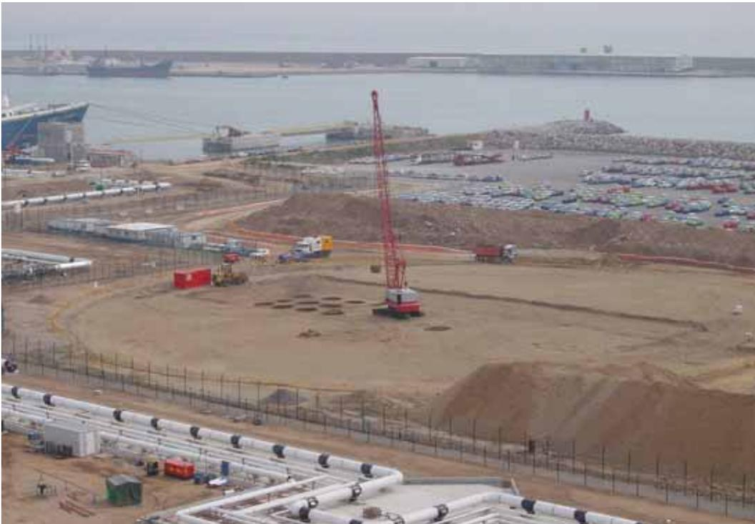
FIGURA 10. TK-3000 Ejecución de la compactación dinámica.
