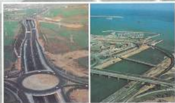
Obra de infraestructura M-40 Madrid
