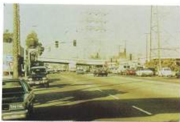
FIGURA 5. Paso inferior Fairfax-Washington. Vista general del estado del viaducto.
