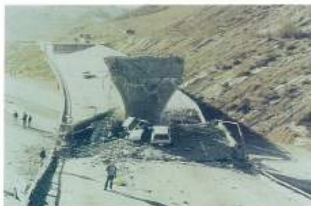
FIGURA 18. Enlace I-5/SR-14 Sur. Columna 4 aislada tras el colapso.
