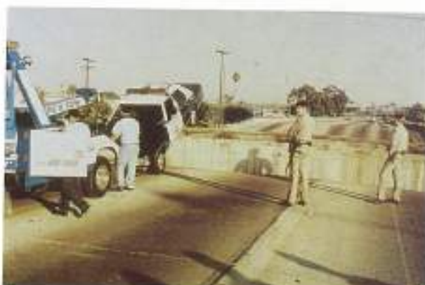
FIGURA 7. Paso inferior Fairfax-Washington. Levantamiento del tablero en un estribo.
