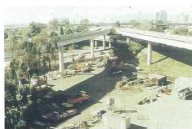
FIGURA 26. Enlace I-10/405. Columnas reforzadas con camisa metálica, en estado intacto tras el sismo.
