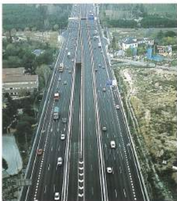
CN VI, Madrid. Tramo Aravaca - Las Rozas
