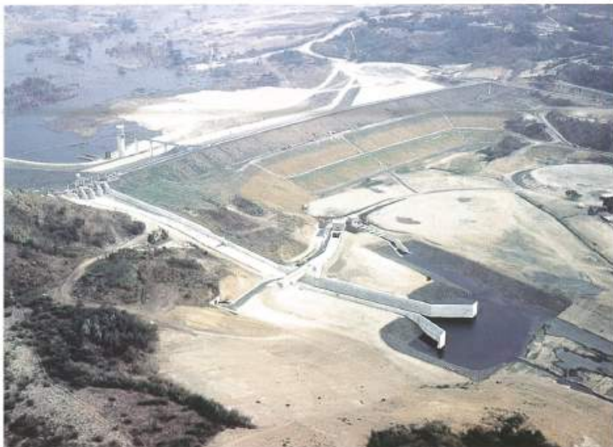
Presa de la Esperanza. Ecuador
