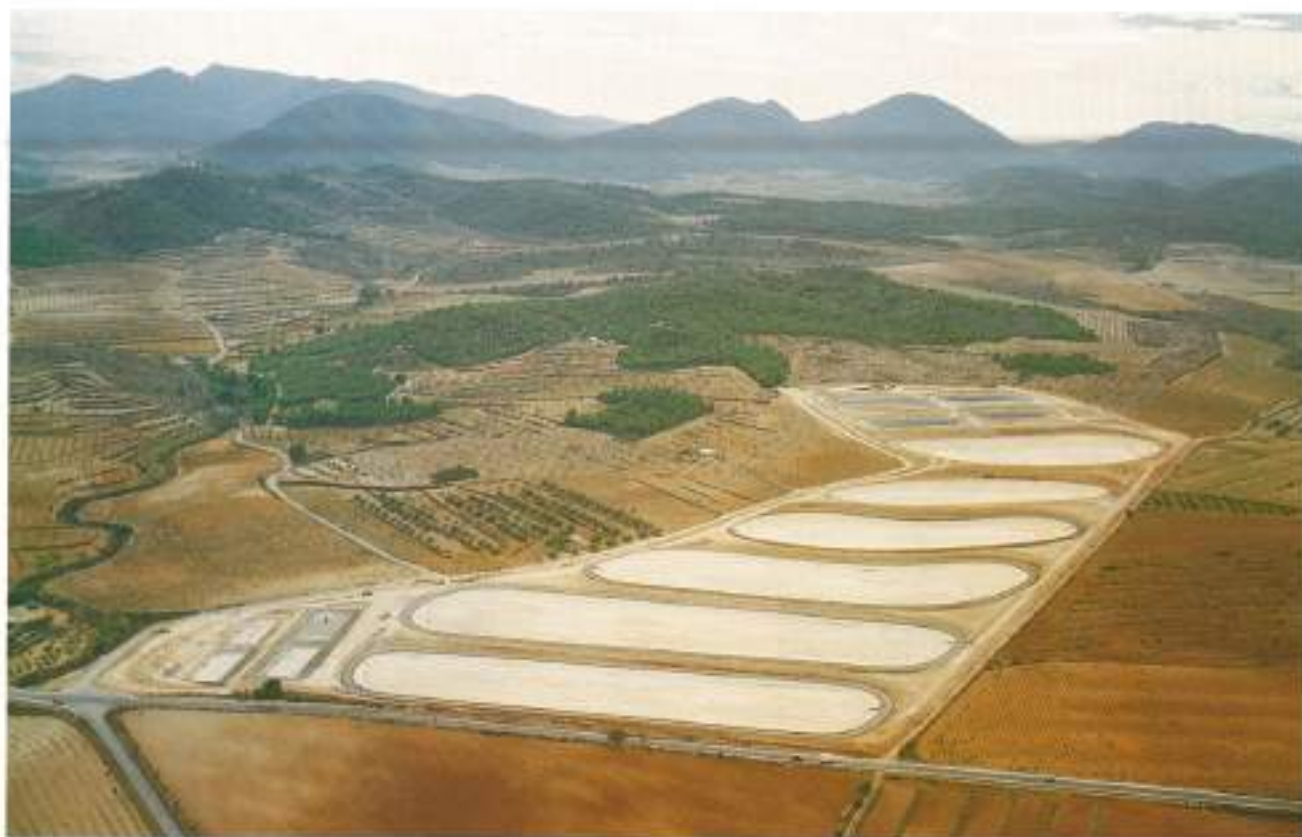
Depuradora de aguas residuales Balsa MURCIA 120.000 m 3 (impermeabilizada con lámina DRAYFIL Embalses)
