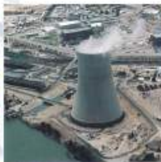
Torre de Refrigeración C.N. Ascó (Tarragona)
