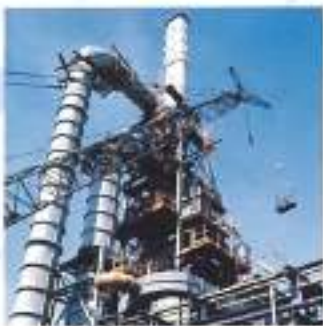
Refinería de Petróleos de Concón (Chile)
