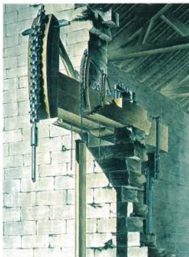
Balancín de la máquina de vapor de la fundición de Yndría. Descripción del establecimiento de Yndría, donde se funden y barrenan los cañones de hierro para la Marina Real de Francia. Agustín de Betancourt, 1791. Biblioteca del Palacio Real de Madrid, IX-Mesa 97
