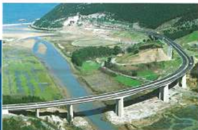
Autovia del Cantábrico. Tramo: Castro Urdiales-Colindres (Santander)
