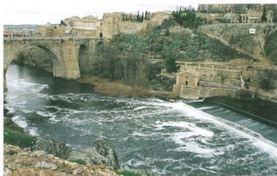
FOTO 5. Tajo en Toledo. Puente de S. Martín, diciembre 1994. Clasificación: litosoligénico II. \text{Na}^+ : \text{Mg}^{2+} , \text{SO}_4^{2-} : alto. Continuidad: espuma.
