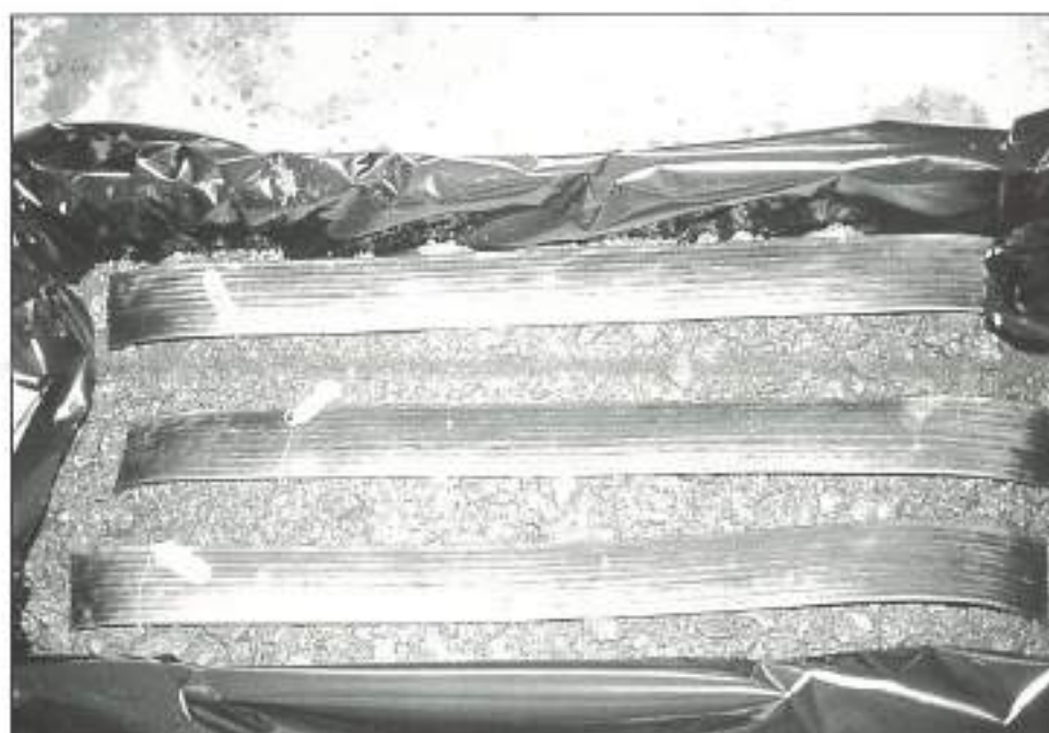
FOTO 3. Estéril negro. Armadura banda "paraweb".
