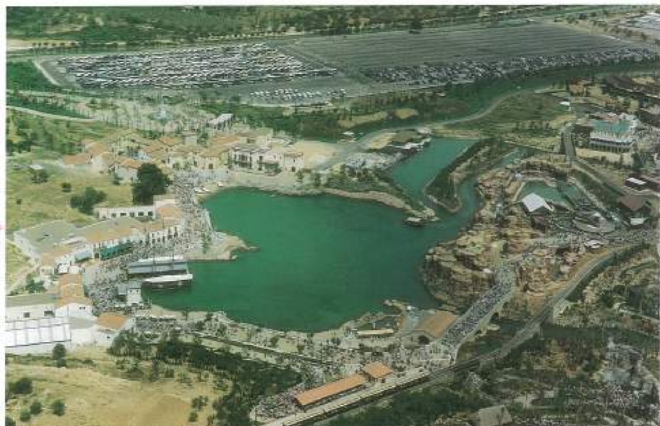
PORT AVENTURA (TARRAGONA). 1994. 82.000 m 2 impermeabilizados con DRAYFIL.
