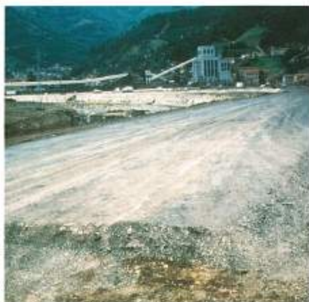
FOTO 5. Capa de subbase de estéril-cemento ya compactada.
