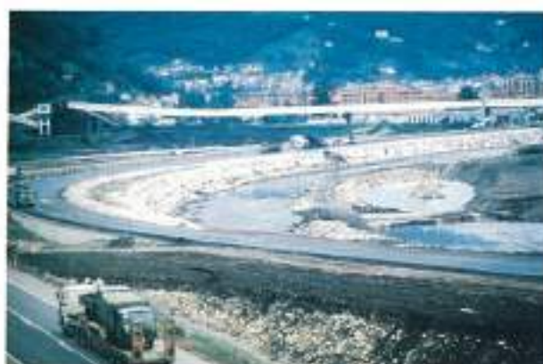
FOTO 6. Construcción del tramo de autovía entre Baña y Mieres donde fueron empleados los estériles-cemento.
