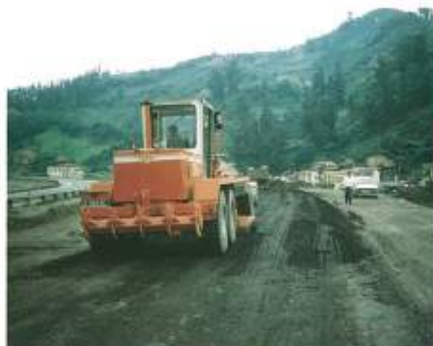
FOTO 4. Puesto en obra de la mezcla estéril-cemento.
