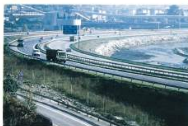
FOTO 7. El mismo tramo de la fotografía 6, una vez concluida y abierta al tráfico.
