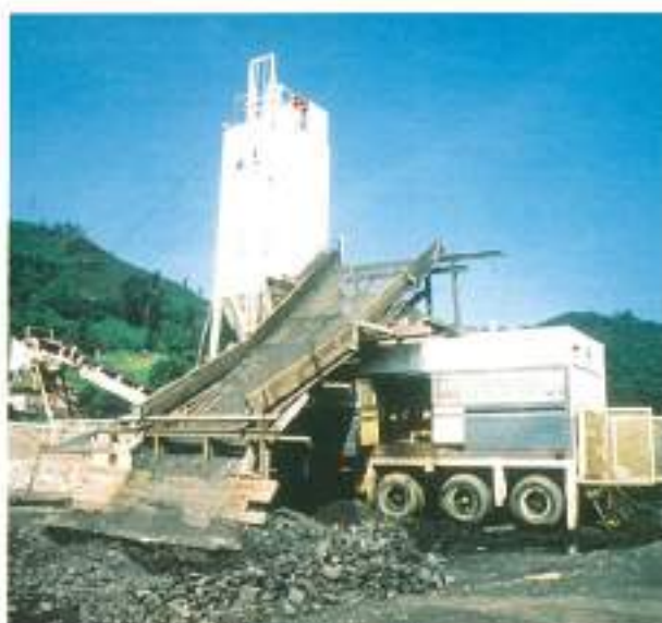
FOTO 3. Criba para la eliminación del material con tamaño mayor de 80 mm.
