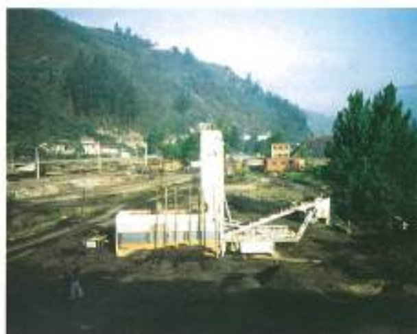
FOTO 2. Planta utilizada para la fabricación de la mezcla estéril-cemento.
