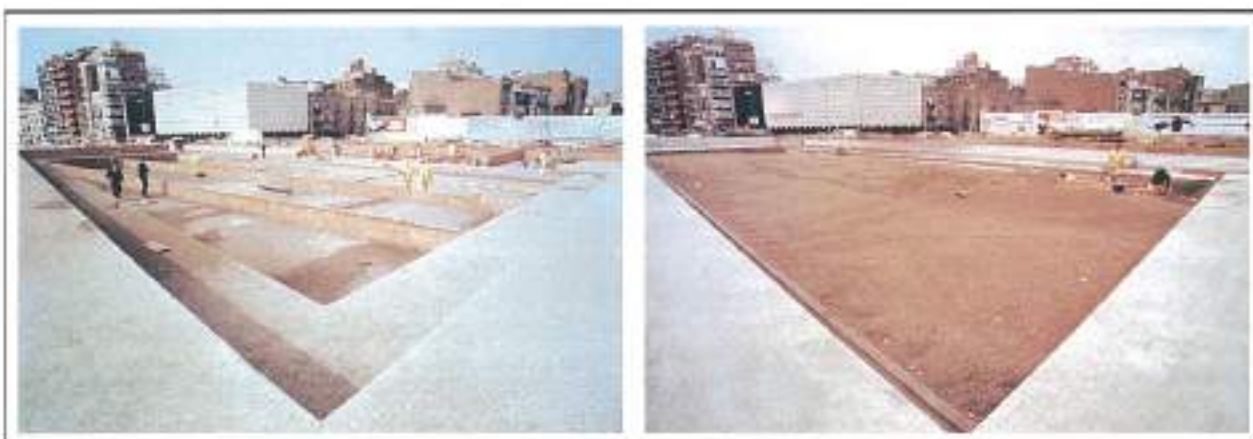
FOTO 4. Relleno ligero sobre un aparcamiento, Barcelona 1992.
