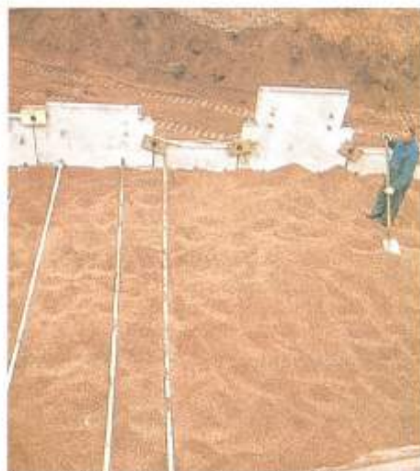
FOTO 8. Relleno ligero bajo una calzada en Polesine, Italia.
