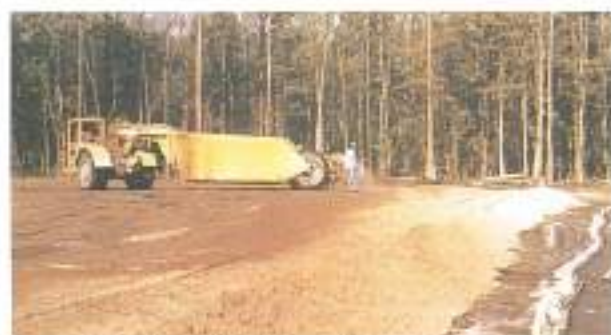
FOTO 5. Relleno ligero de arcilla expandida bajo una autopista sobre terreno pantanoso.
