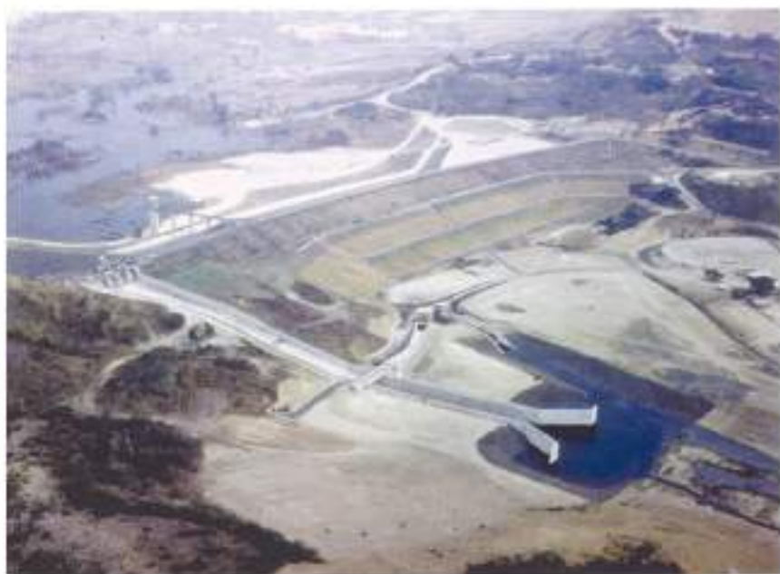
Presa de la Esperanza. Ecuador
