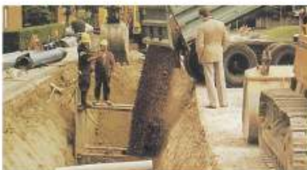
FOTO 6. Relleno ligero en un gasoducto en Calgary, Canadá.
