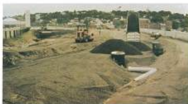
FOTO 3. Relleno ligero de arcilla expandida en el Puerto de Albany, USA.
