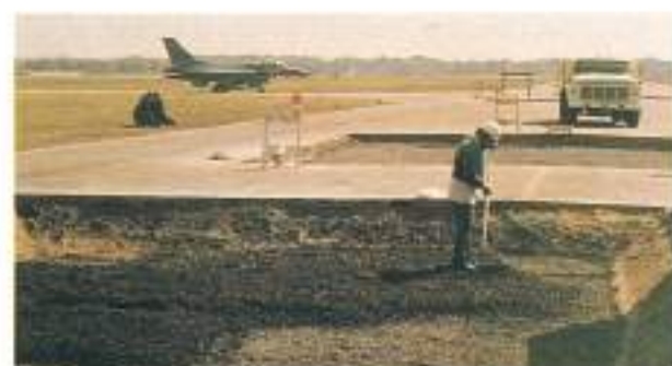
FOTO 2. Reparación de una pista de aterrizaje en Virginia, USA.
