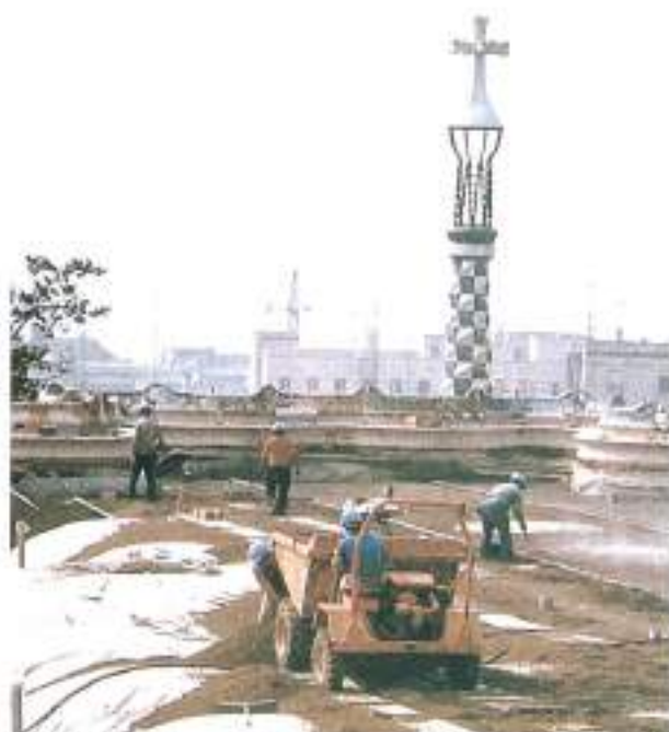
FOTO 7. Relleno ligero sobre la Sala Hipóstila del Parque Güell, Barcelona.
