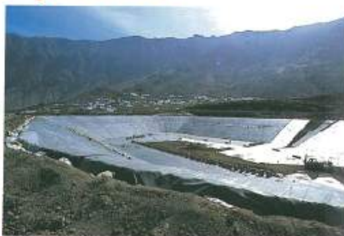
EMBALSE EN LA ISLA DE HIERRO (CANARIAS) PARA AGUA DE RIEGO
