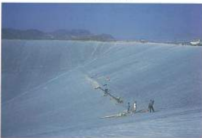
DETALLE INSTALACIÓN ANCLAJE EN ZANJA INTERMEDIA
