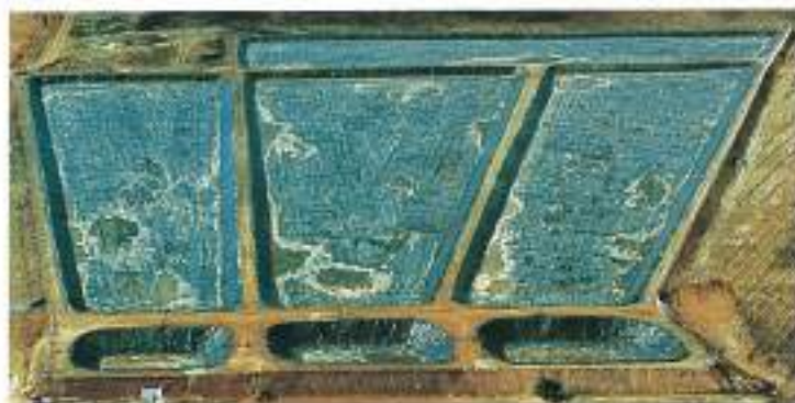
Vertedero de alpechines y balsas de tratamiento. Quero (Toledo).
