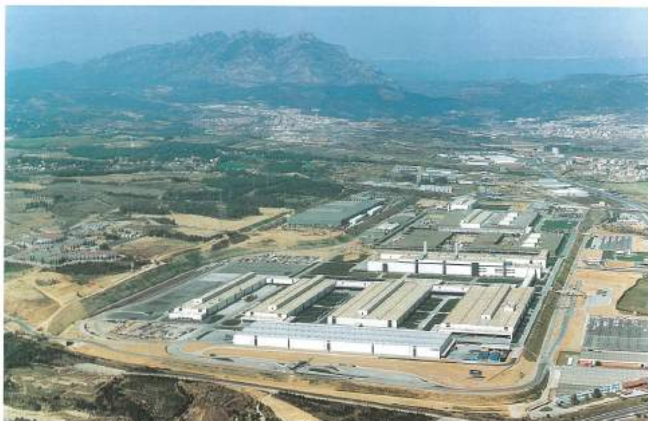
Fábrica de SEAT-VOLKSWAGEN (MARTORELL) 1994. 24.000 m 2 Impermeabilizados con DRAYFIL.
