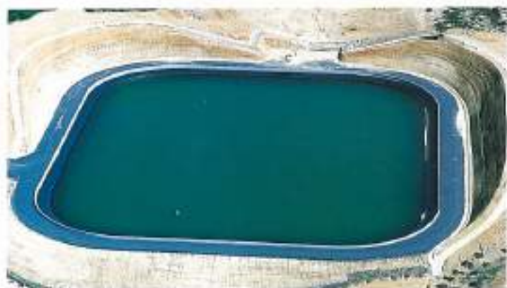
Embalse regulación de agua riego. Lepe (Huelva).
