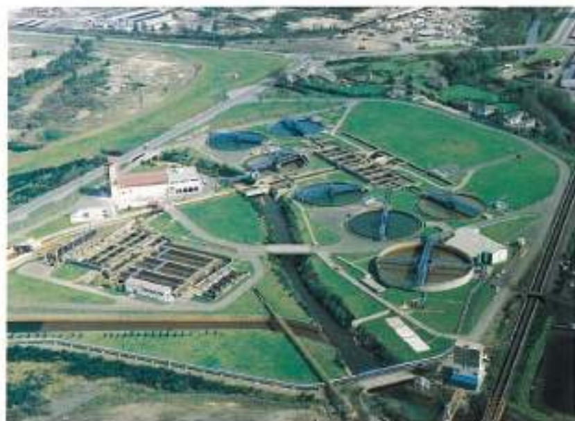
Depuradora de As Pontes. La Coruña
