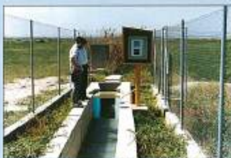
MEDIDA DE CAUDAL POR VENTURI Acequia de Ripoll
