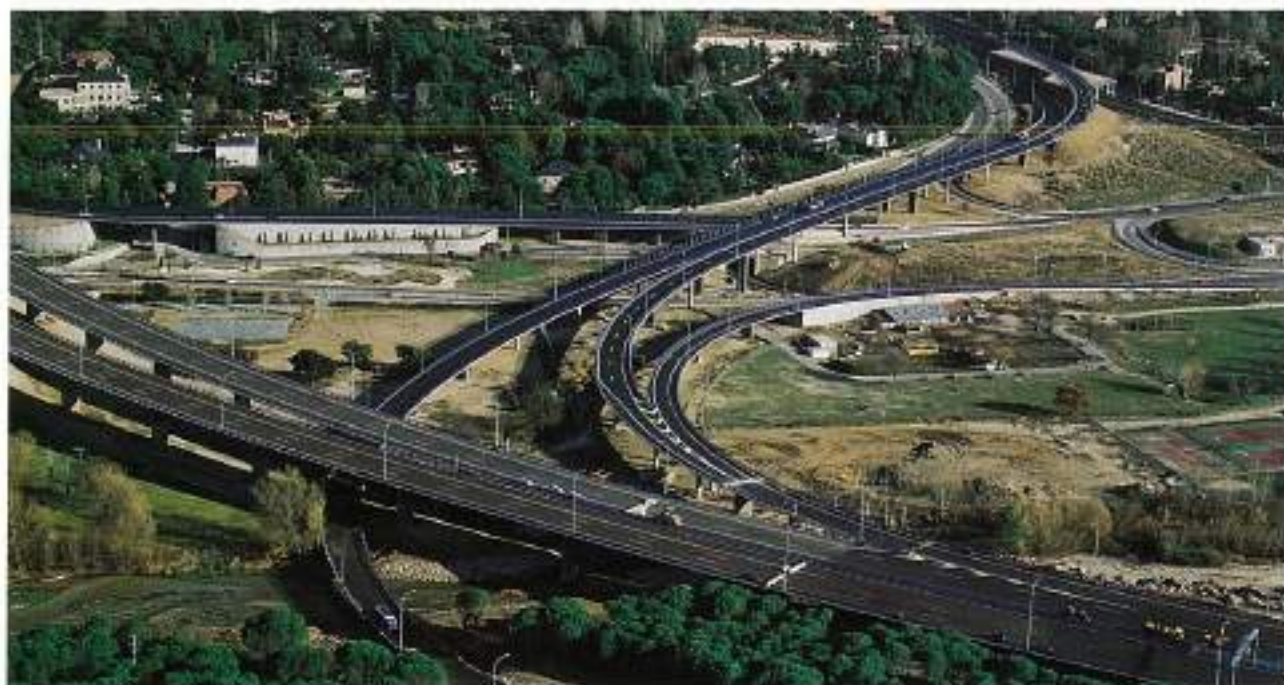
Distribuidor Norte M-40. Tramo; Carretera N=VI - Enlace de la Zarzuela
